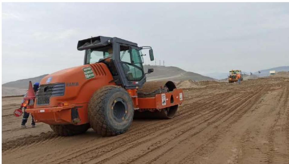
Cuando sea requerido se realizará el mezclado del material mediante disco de arado. Si la superficie de alguna capa de relleno queda demasiado lisa, dicha superficie deberá aflojarse escarificándola antes de colocar sobre ella la capa siguiente.
