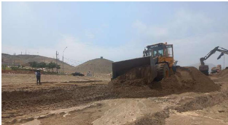
Cada capa del terraplén debe ser humedecido y secada al contenido de humedad requerida según las indicaciones en los planos para asegurar la compactación máxima.
