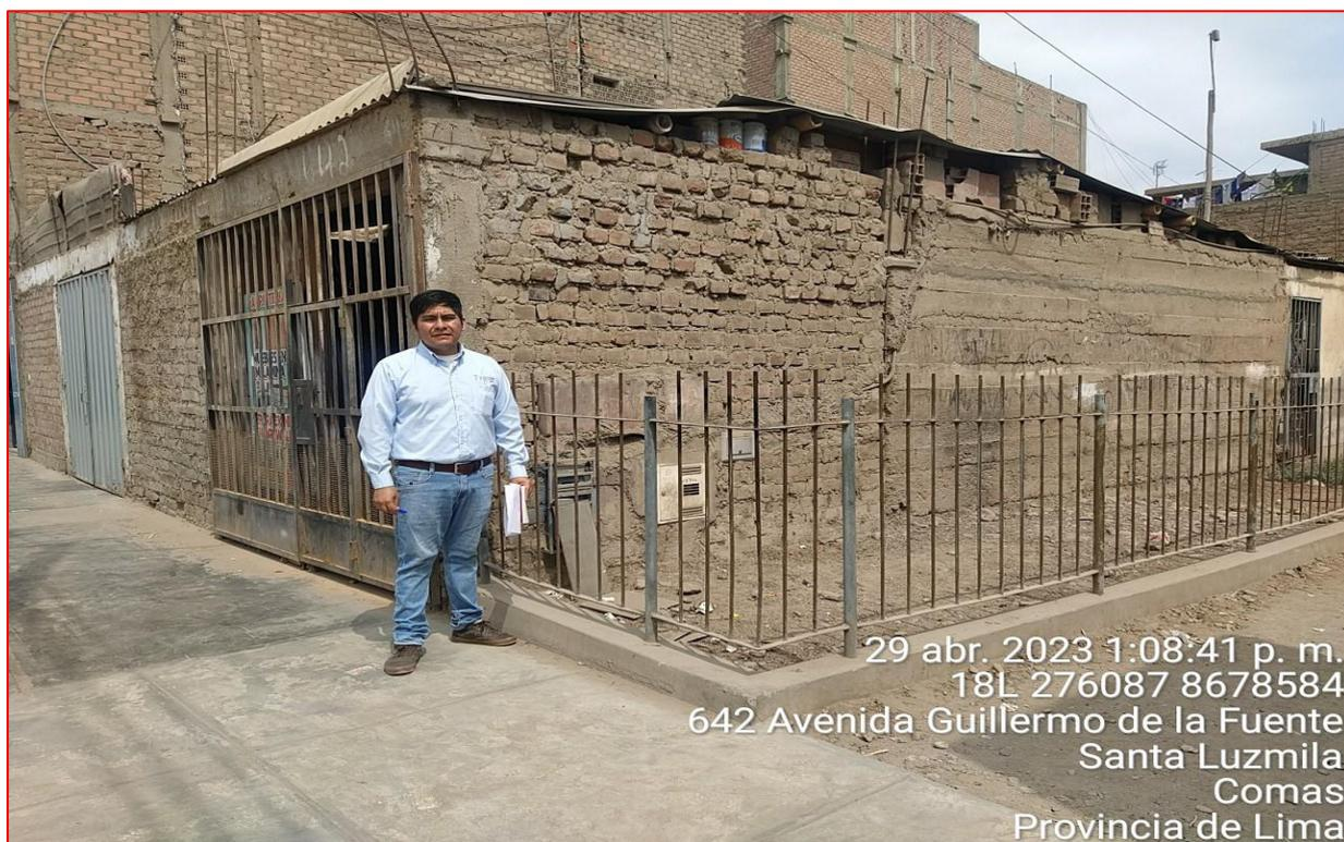
Fotos 6 y 7. Vista de viviendas sin reforzamiento de sus estructuras
