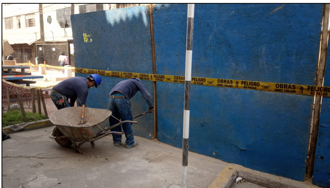
Limpieza de las zonas de trabajo
