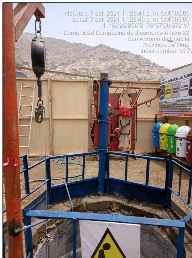
Cámara de excavación
