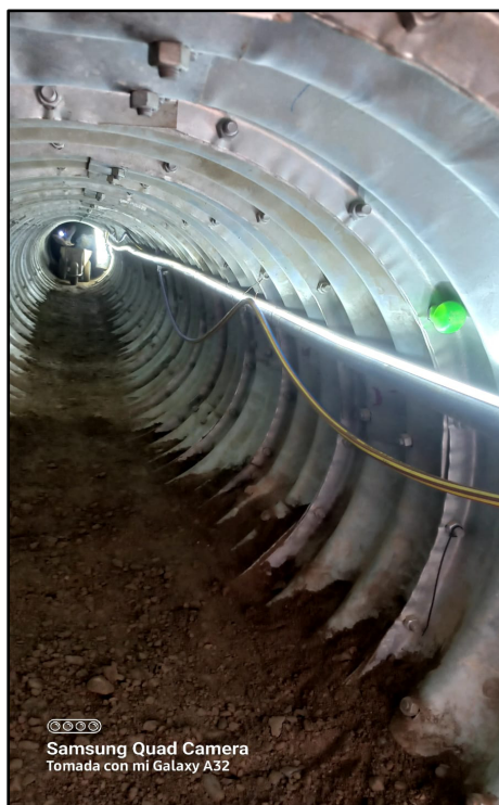
Interior de túnel liner
