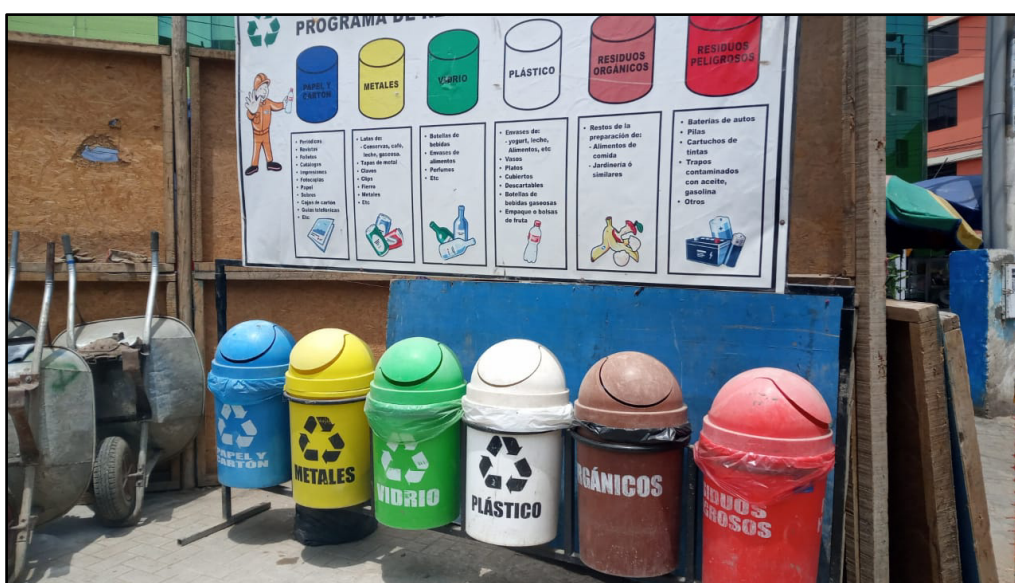
Estación para segregación de residuos sólidos
