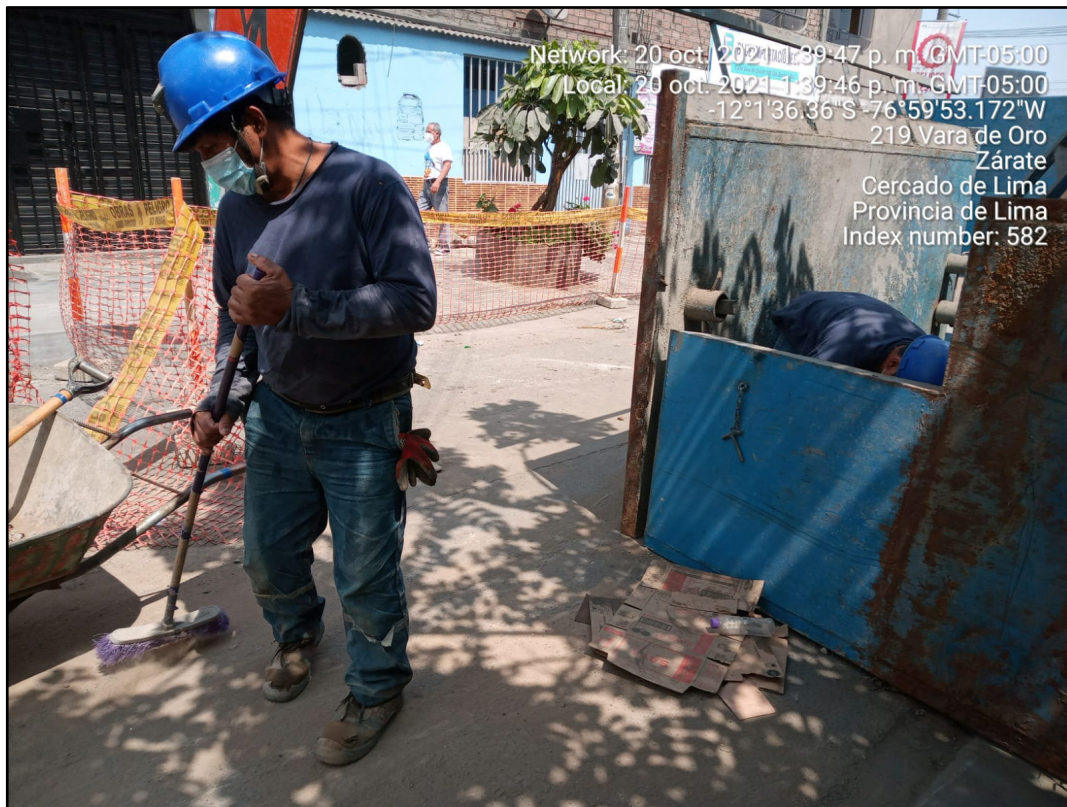
Limpieza de las zonas de trabajo
