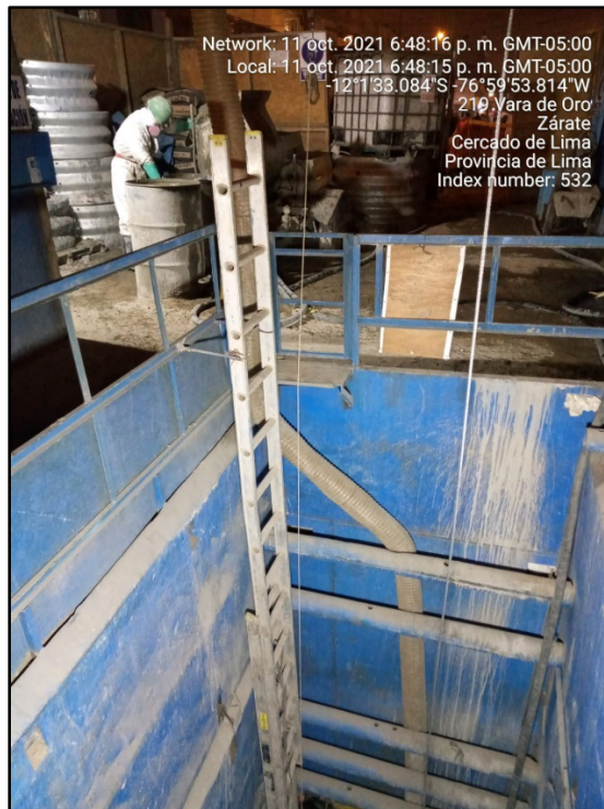
Zona de acceso a portal del túnel liner
