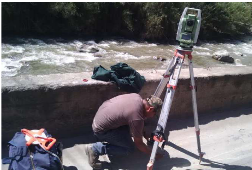
FOTOGRAFIA N° 07 Cambio de E-02, ubicado al costado de la carretera central - (izquierda rio Huallaga) - al frente 16 de Nov.
