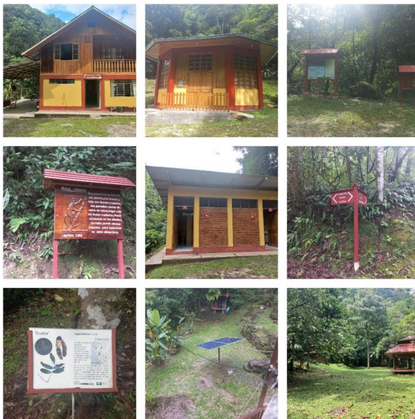
Foto 3: Infraestructura del Sector Huampal – PNYCH
