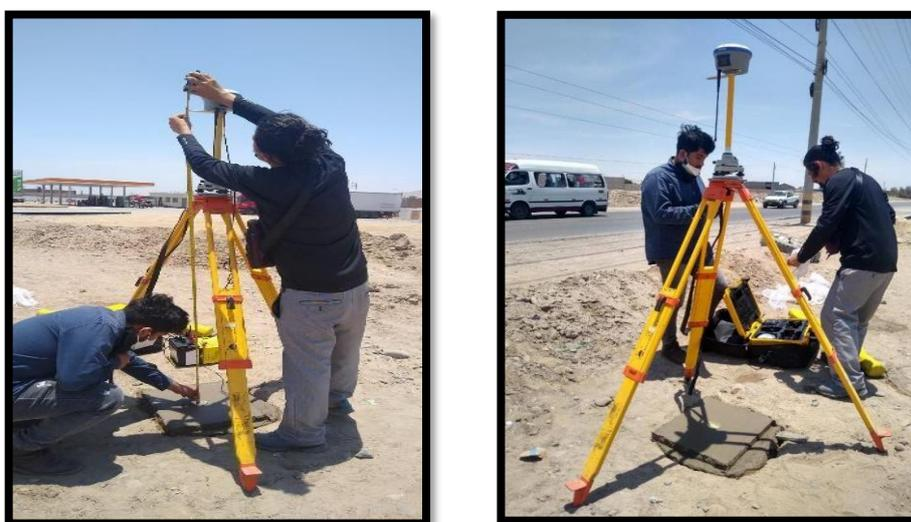
*Nota:* La figura muestra el procedimiento de posicionamiento geodésico empleado en el levantamiento predial, destacando los equipos y técnicas utilizadas para obtener las coordenadas precisas.
