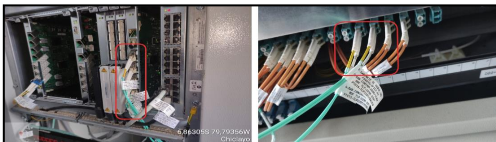
Figura N°32: Implementación de conexionado de Protección Diferencial
