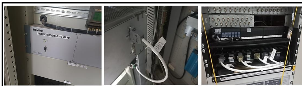
Figura N°30: Implementación de conexionado de TLP X.21
