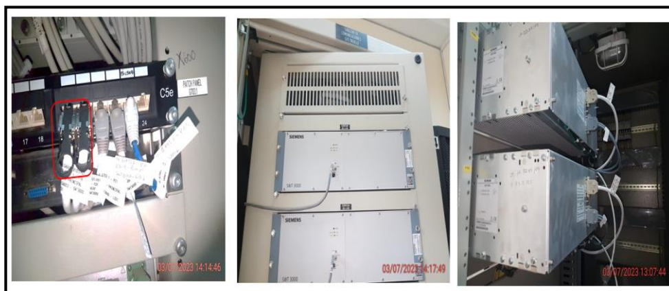
Figura N°28: Implementación de conexonado de TLP en G703.CO.
