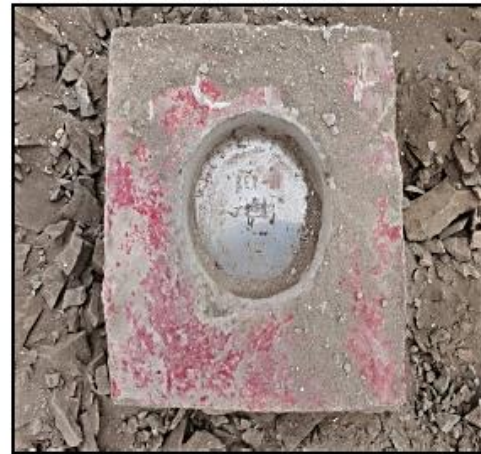
FOTOGRAFIA 2. Utilización de un pilar de concreto con fierro incrustado e inscrito el nombre de PC1-CA
