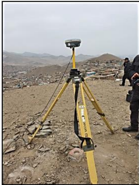
FOTOGRAFIA 1. Instalación del equipo GPS TRIMBLE R8s en el punto geodésico PC1-CA (base).
