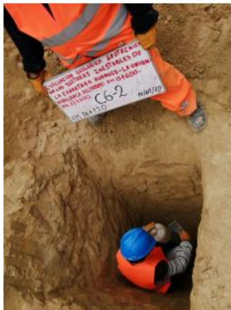
Foto N° 8. Vista del ensayo de densidad D -1 en la Calicata C-2, KM. 26+900 – KM. 26+990
