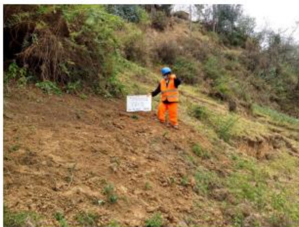
Foto N° 10. Vista panorámica de la Calicata C -3, KM. 26+900 – KM. 26+990
