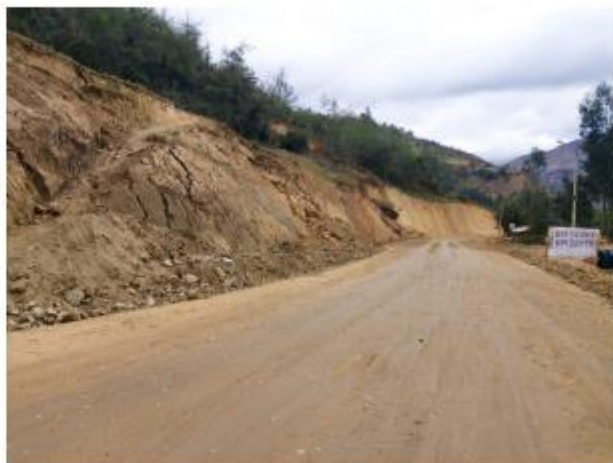
Foto N° 1. Vista panorámica, KM. 26+900 – KM. 26+990
