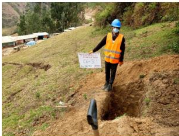
Foto N° 11. Vista de la excavación de la Calicata C -3, KM. 26+900 – KM. 26+990
