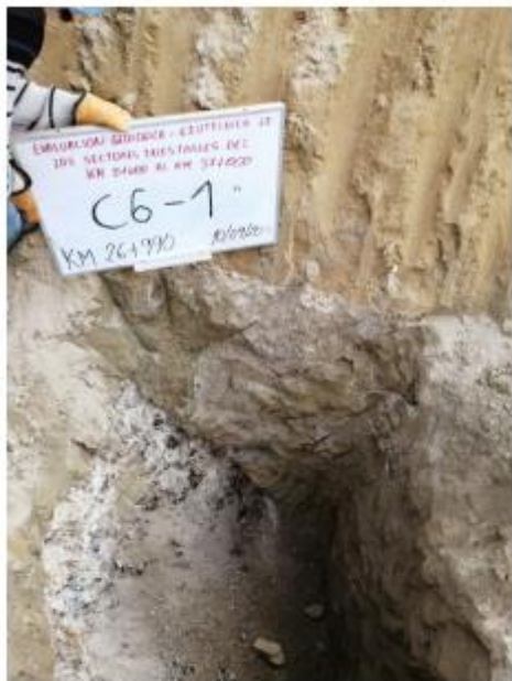
Foto N° 3. Vista de la Calicata C-1, KM. 26+900 – KM. 26+990
