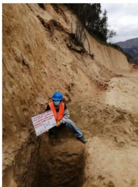
Foto N° 6. Vista de la Calicata C-2, KM. 26+900 – KM. 26+990
