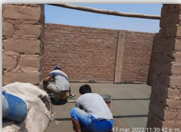
A) Pavimentación del piso con
