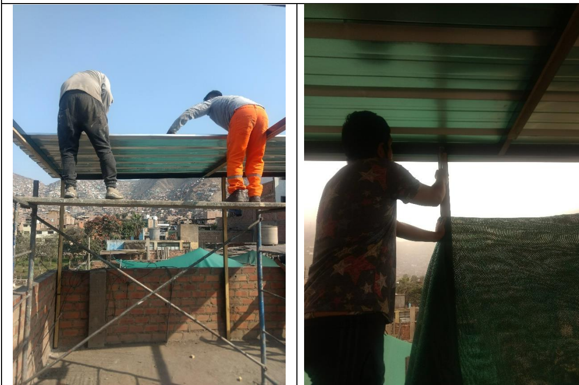
Implementación de la infraestructura del invernadero
