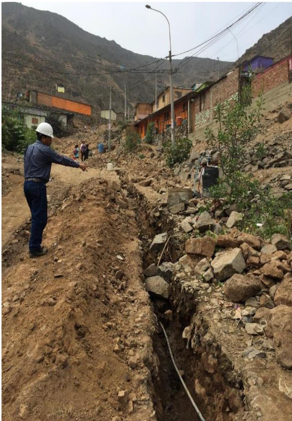
*Nota:* Excavación de zanja para instalación de red complementaria de alcantarillado de  $\varnothing 160$  mm de módulo sanitario que se empalmará a red pública de SEDAPAL mediante conexión domiciliaria. Fuente: SEDAPAL 2018
