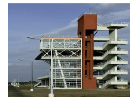
Torre de control
