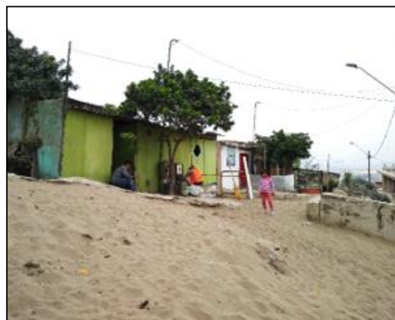
Fotografía 13. Predios del A.H. Mirador de Villa que colindan con la zona de riesgo.
