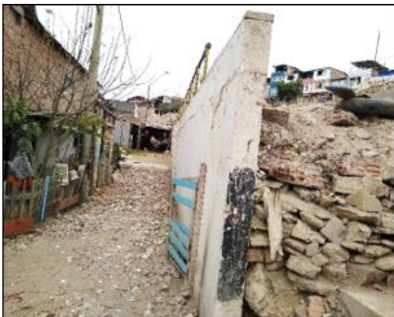
Fotografía 12. Predios del A.H. La Encantada Grupo II que colindan con la zona de riesgo.
