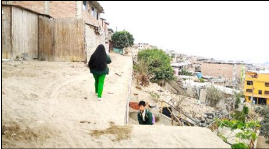
Fotografía 10. Escaleras de acceso sin barandas.
