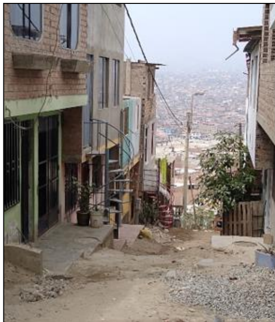
Fotografía 7. Calle del A.H. Collasuyo 28 de Diciembre ocupada por escaleras de acceso a viviendas.
