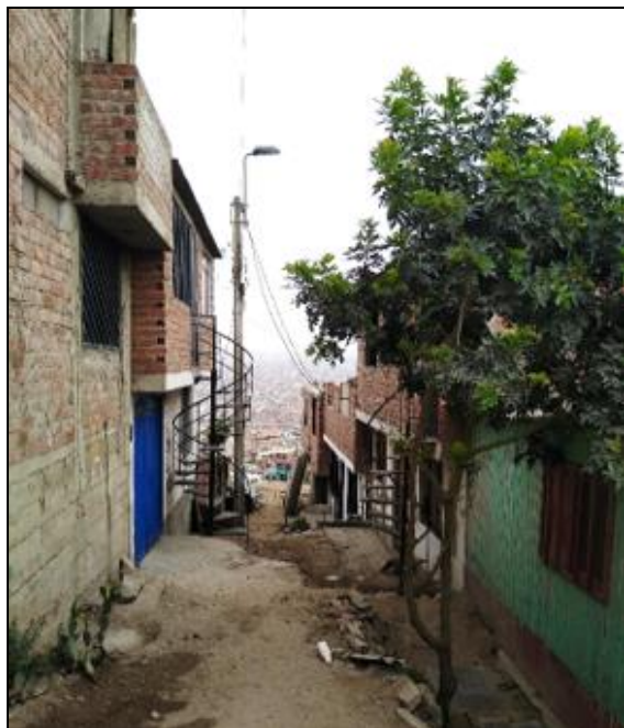
Fotografía 6. Calle del A.H. San Ignacio de Loyola ocupada por escaleras de acceso a viviendas.
