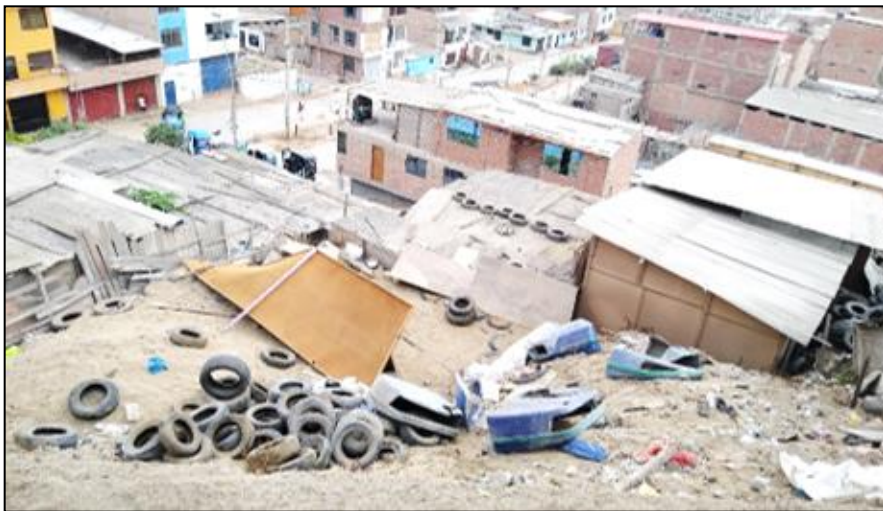
Fotografía 11. Predios del A.H. La Encantada Grupo I que colindan con la zona de riesgo.
