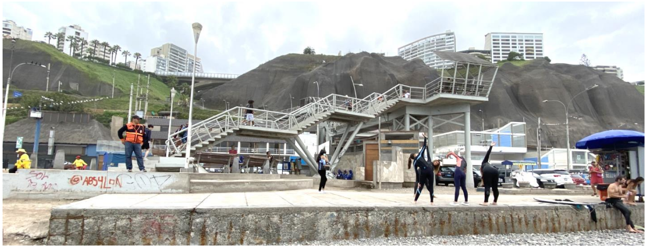
Figura 55 Puente Balta, distrito de Miraflores. Fecha: febrero 2020
