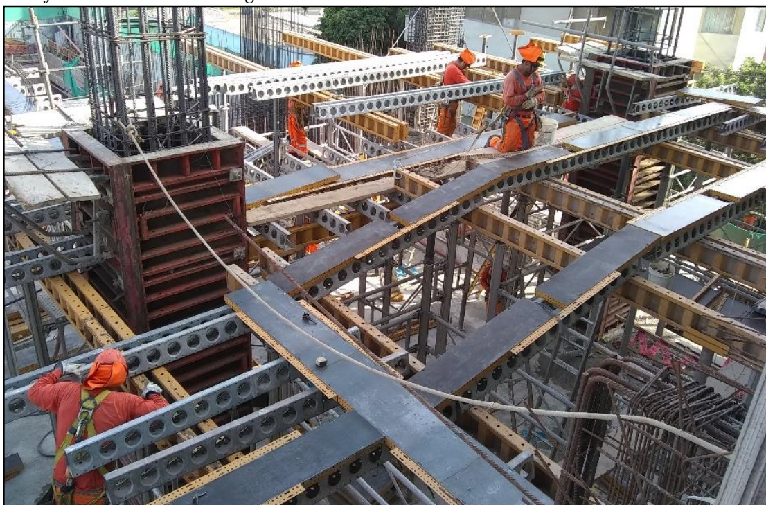
Figura 61 Encofrado de Fondos de Viga del Techo del Piso 2.
