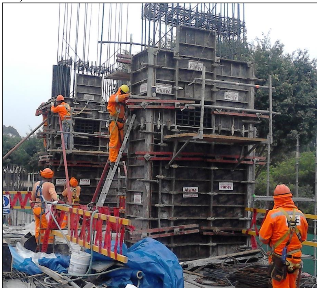
Encofrado de Placa en Piso 2.
