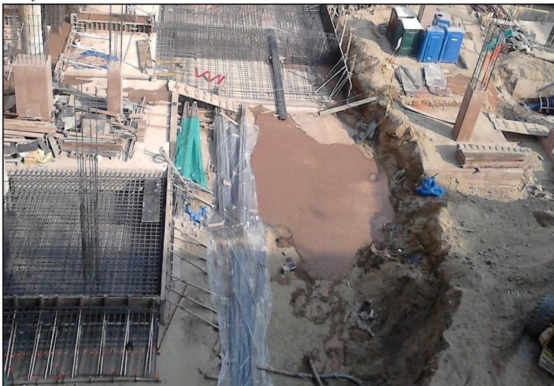
Encofrado de Cimentaciones en Subsector 2C.
