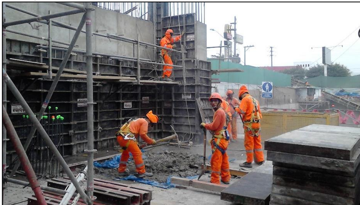
Figura 57 Desencofrado de Placa en Piso 1
