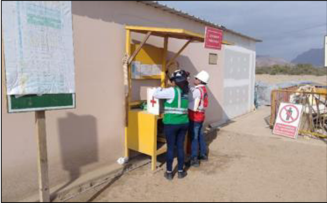
Fotografía 3. Implementación de controles operacionales, estación de emergencia PTAP.
