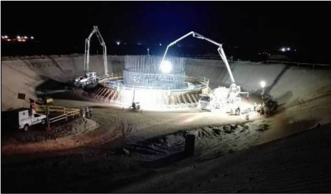
Fotografía 11. Construcción de Reservorio 1.
