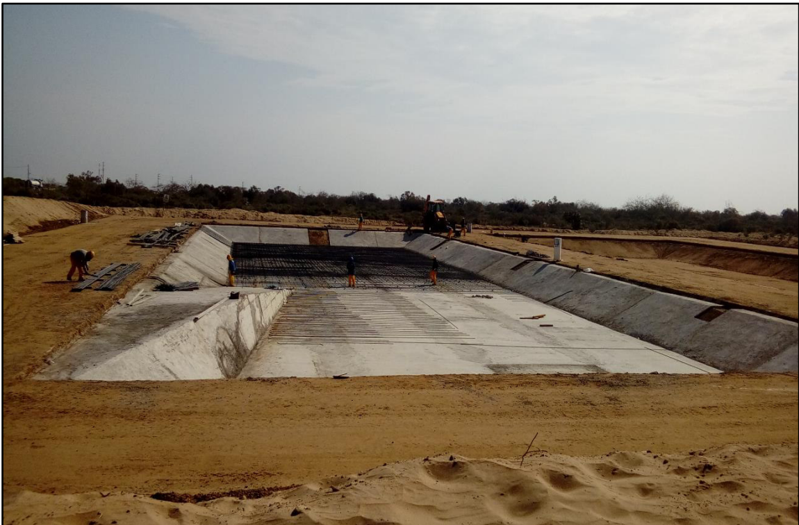
Fotografía 8. Construcción de Lagunas de Oxidación – PTAR
