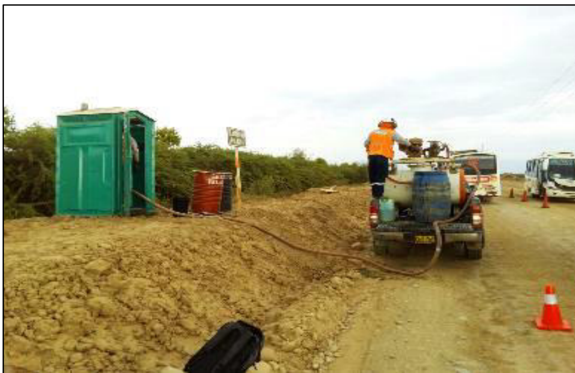
Fotografía 6. Implementación de controles operacionales, limpieza de baños químicos.
