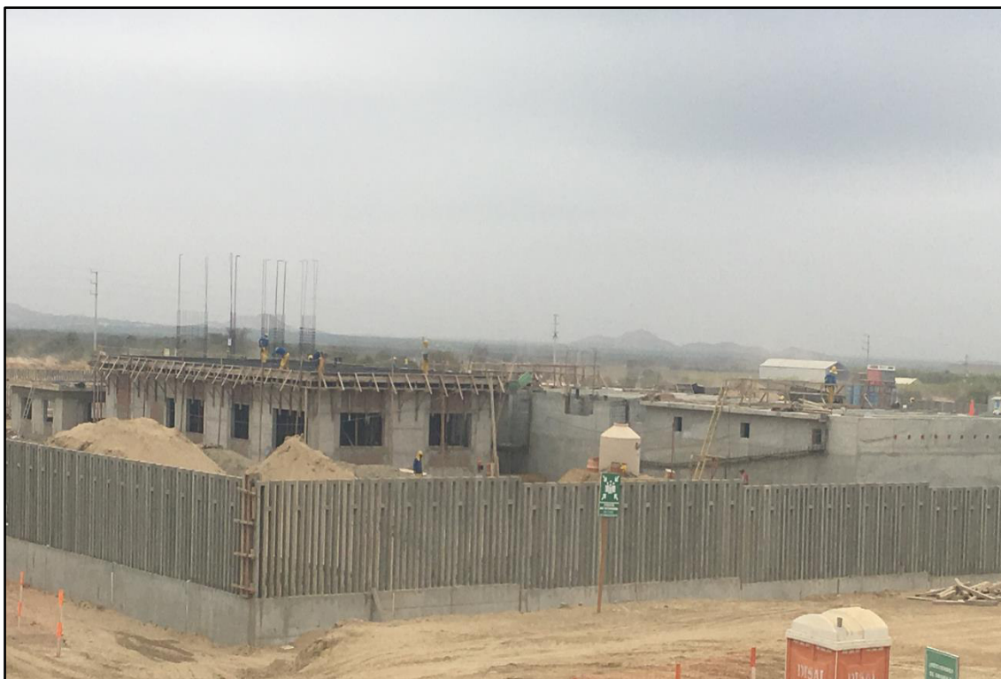
Fotografía 9. Construcción de Planta de Tratamiento Agua Potable (PTAP).
