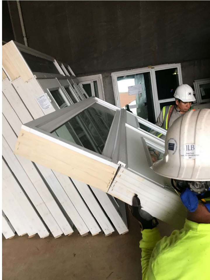
Figura 38: Ensamblaje de Puertas en nuestros almacenes – USA.
