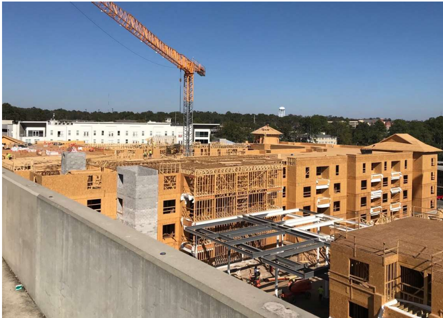
Figura 35: En estas fases se procede con las inspecciones en obra, ver aperturas y progreso.
