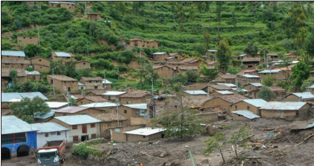
Figura 121: Viviendas construidas en ladera-Ayacucho. Fuente: (Agencia Peruana de Noticias Andina, 2019).
