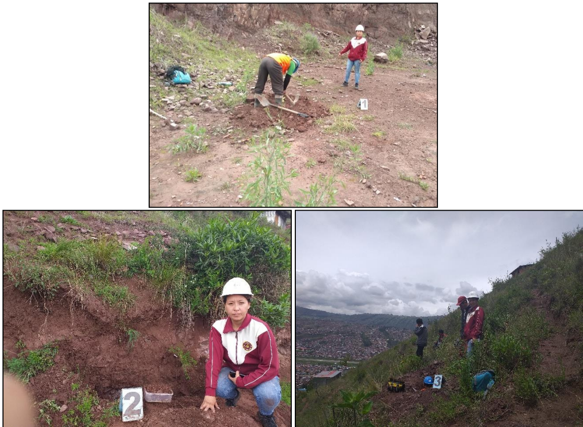
Figura 141: Exploración a cielo abierto. Fuente: Estudio de Mecánica de Suelos.
