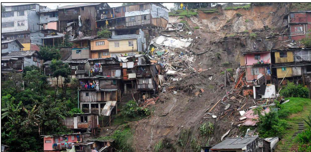
Figura 117: Deslizamiento de tierra Manizales-Colombia. Fuente: (Semana, 2017).
