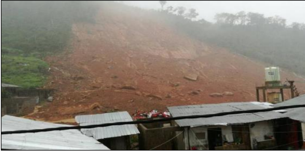
Figura 118: Construcciones ilegales fueron afectadas por deslizamiento-Sierra Leona-México. Fuente: (La Vanguardia, 2017).
