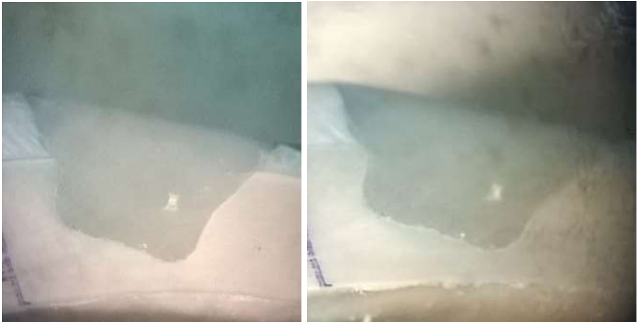
FOTOGRAFIA N°4 Grado de Microfiltración 4
