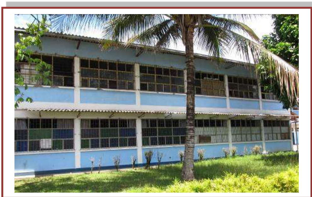
Vista del pabellón – Fachada posterior N° 02
