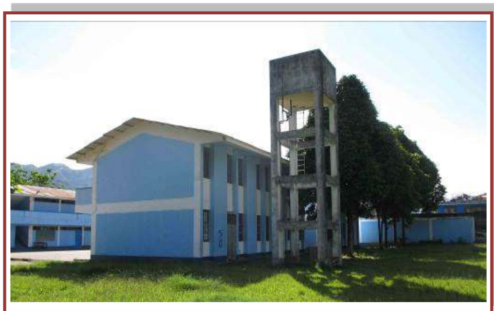
Vista del pabellón – Fachada posterior N° 07
