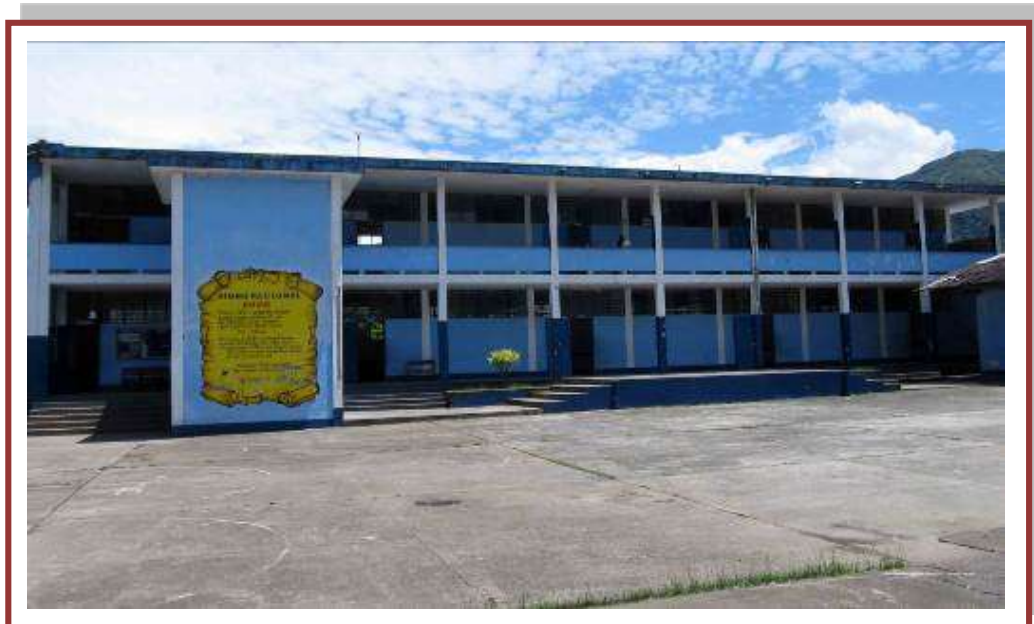
Vista del pabellón – Fachada Posterior N° 01
