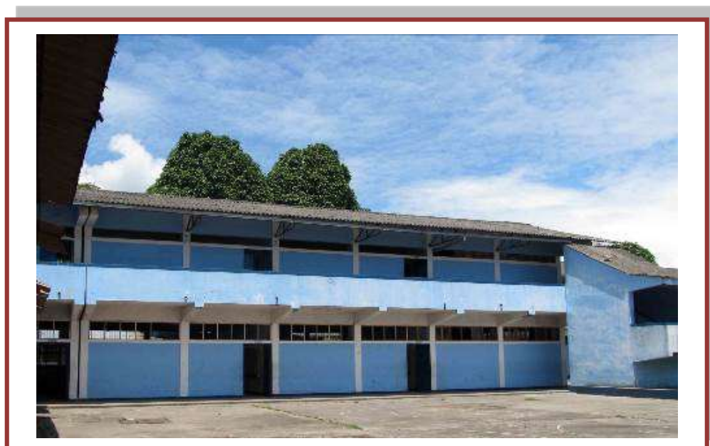
Vista del pabellón – Fachada posterior N° 03
