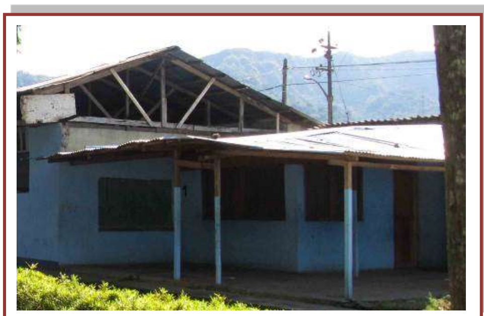
Vista del pabellón – Fachada lateral N° 15
