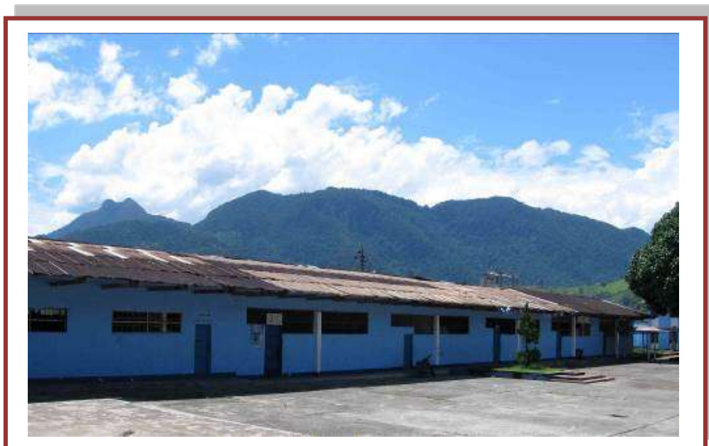
Vista del pabellón – Fachada posterior N° 05
