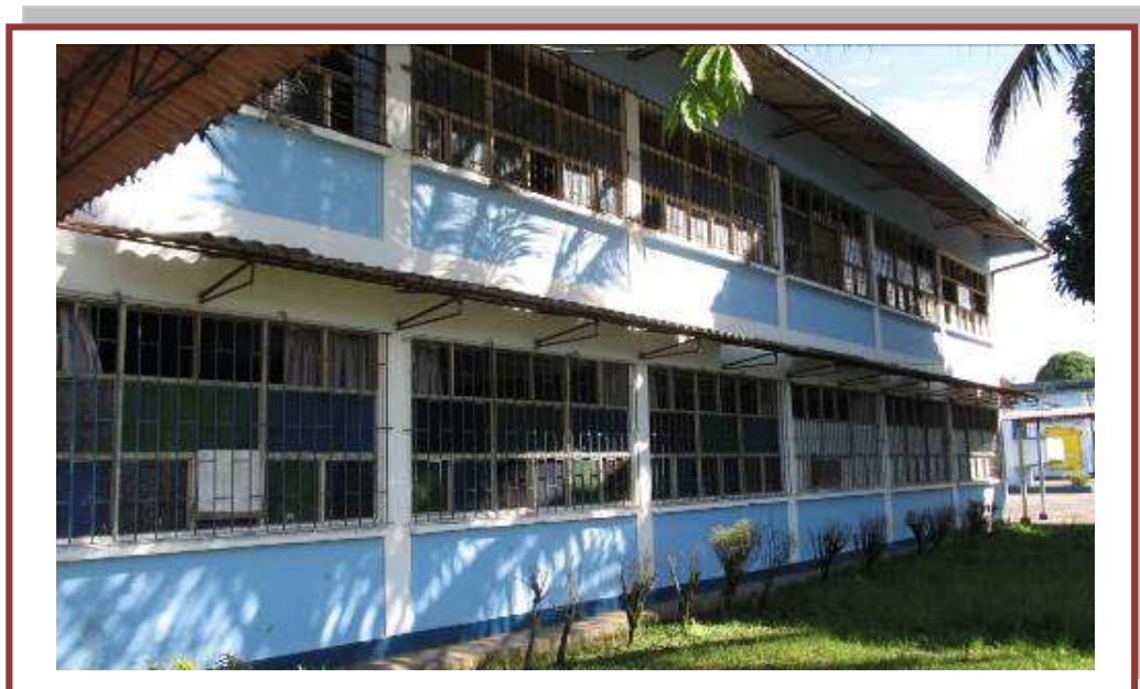
Vista del pabellón – Fachada posterior N° 04
