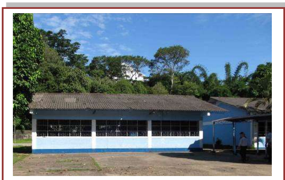
Vista del pabellón – Fachada posterior N° 09
