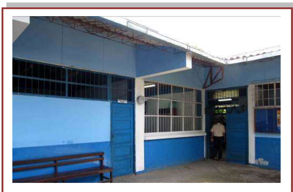
Vista del pabellón – Fachada posterior N° 10
