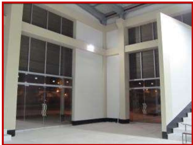
Figura 88: Ingresos laterales al polideportivo del colegio San Juan Trujillo.
