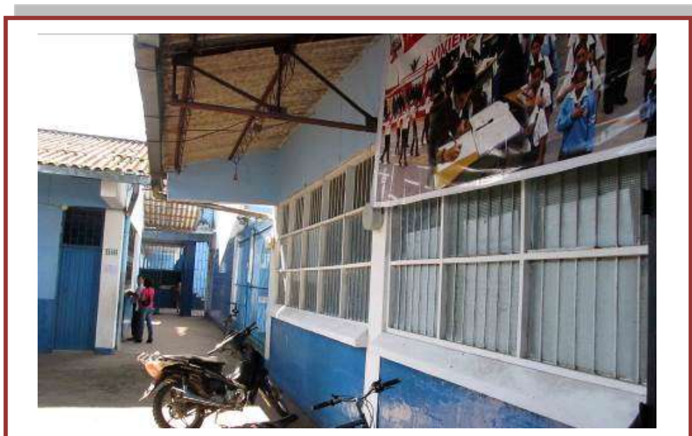
Vista del pabellón – Fachada posterior N° 12
