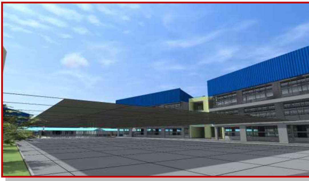
Figura 214: Vista del patio principal – Cobertura de lona
