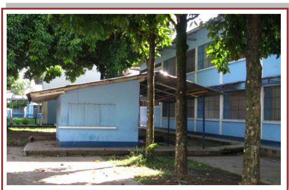
Vista del pabellón – Fachada lateral N° 16
