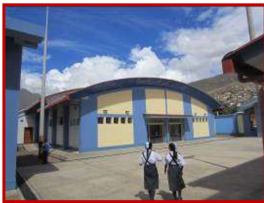
Figura 78: Fachada principal del auditorio del Colegio Leoncio Prado.
