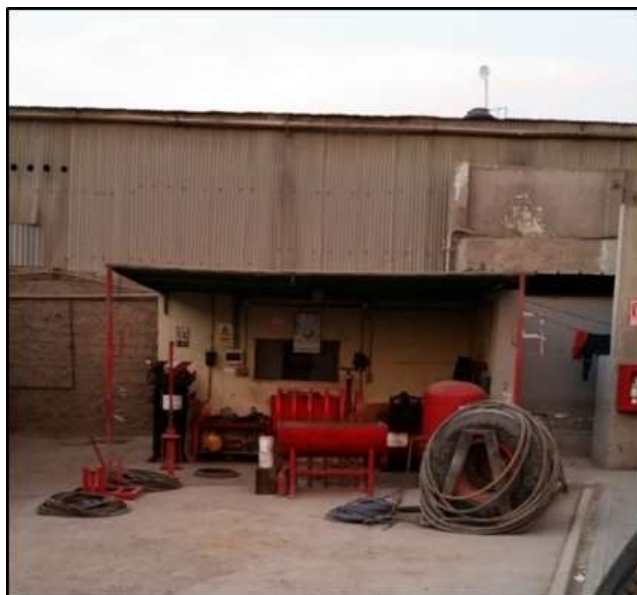
Imagen 29: Taller de mantenimiento, Llantería.
