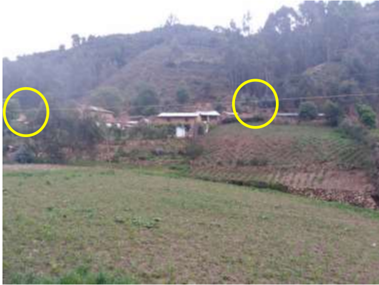
Figura 50 Postes de luz en Mayupampa. Fuente: Elaboración propia.
