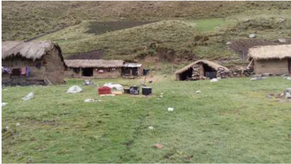
Figura 57 Casas con techo de paja y muros de adobe Tapia. Fuente: Elaboración propia
