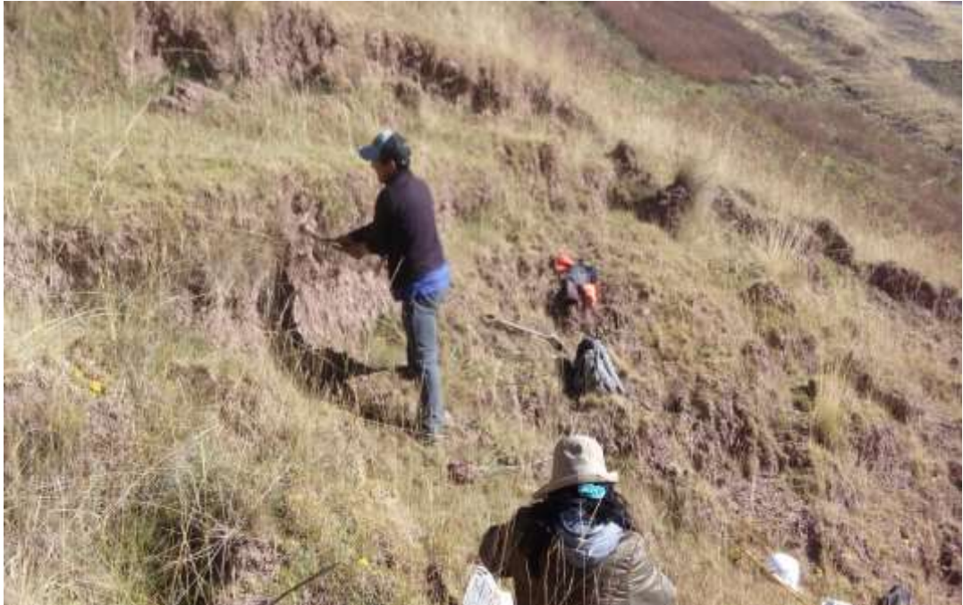
FOTO 29 Realizando calicata en la parte baja en el centro poblado Libertad
