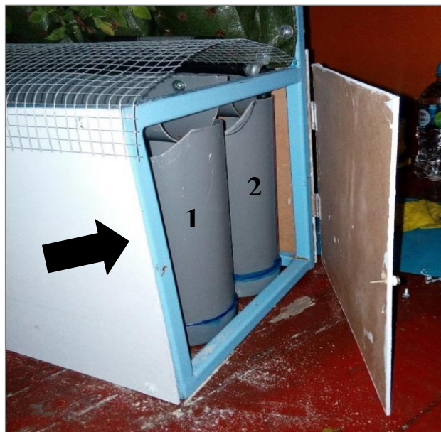
Figura 40. Recipientes colectores del agua de drenaje. Fuente: Elaboración propia.
