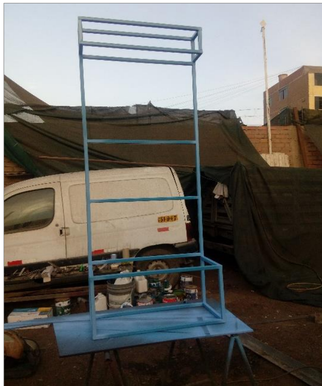
Figura 32. Estructura metálica del jardín vertical piloto. Fuente: Elaboración propia.
