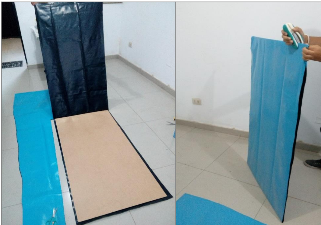
Figura 33. Elaboración de la capa impermeabilizante. Fuente: Elaboración propia.
