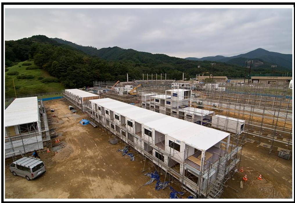
Ilustración 42: Contenedor de alojamiento temporal en construcción
