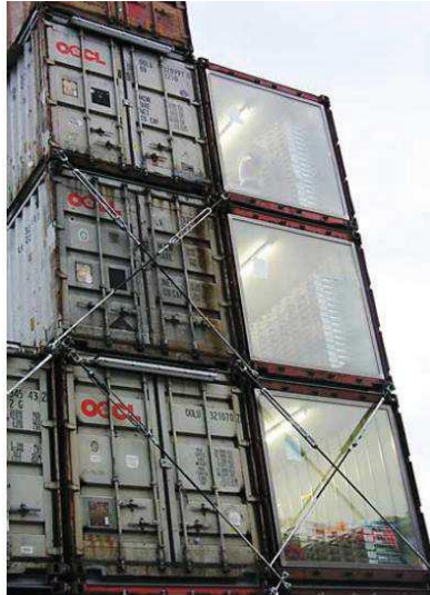
Ilustración 14: Unión de contenedores por puntos fijos
