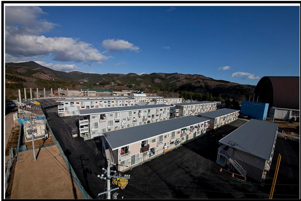
Ilustración 41: Onagawa contenedor de alojamiento temporal
