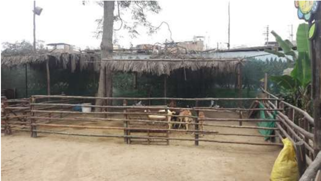
Figura 38: Tipología constructiva- Granja del Parque zonal Sinchi Roca, Comas
