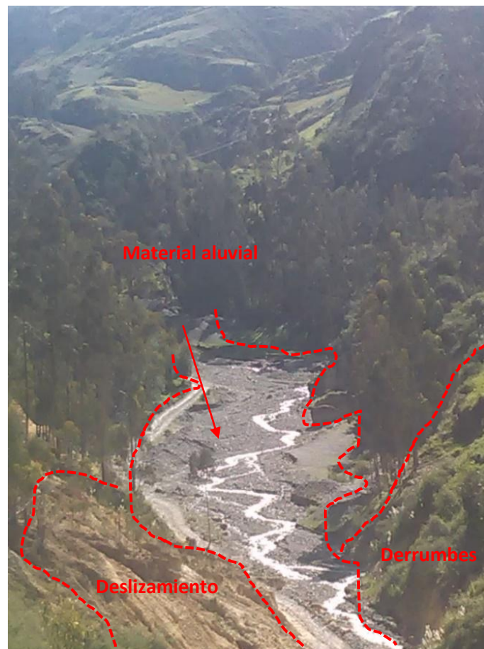
Figura 20: El Río Aco presenta una gran cantidad de materiales no metálicos (arena, cantos rodados y otros). En ambas márgenes se observan deslizamiento y derrumbes
