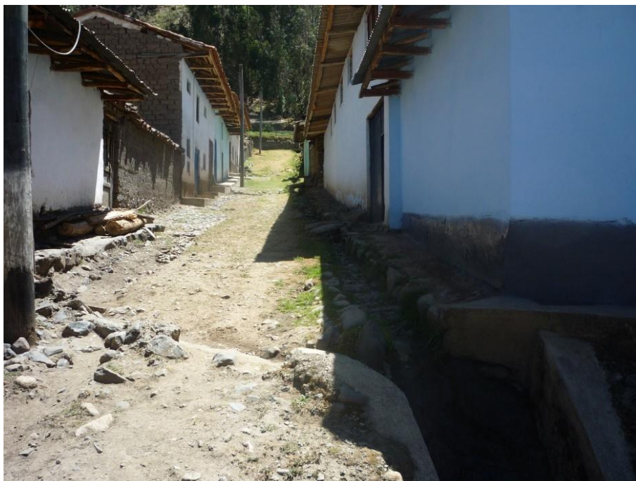
Jr. Belén, Barrio Tumán . Villa Olleros. Gran parte de la calle ha perdido el empedrado y la acequia pasa al costado de las casas.
