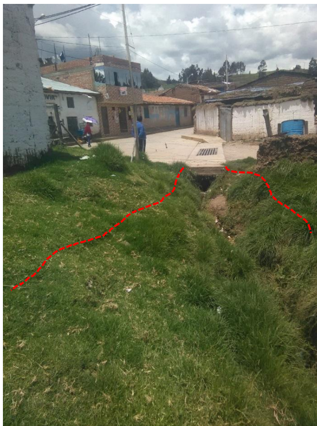
Figura 22: Uno de los ramales de la Quebrada Uchus Utcu. Se observa la erosión remontante del suelo. C.P Huaripampa
