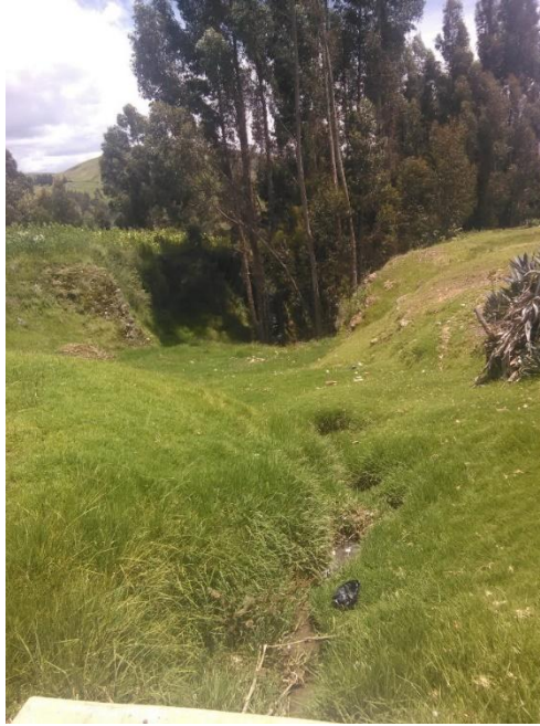
Segundo ramal de la Quebrada. Ucush Utcu- en proceso de erosión remontante. Bosque de eucaliptos en el cauce como medida de control. Huaripampa.
