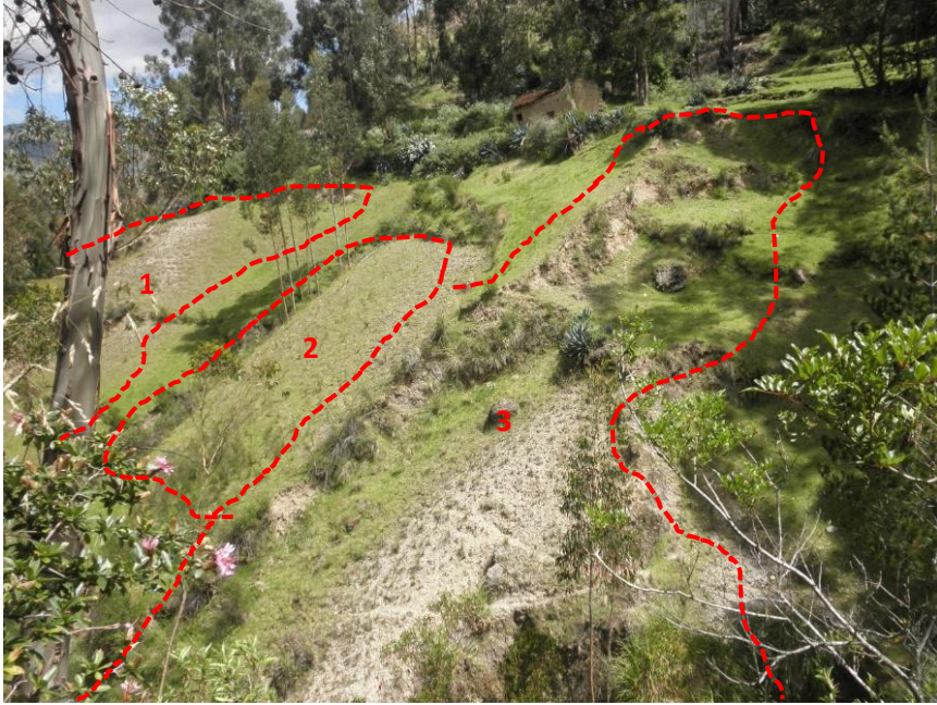
Suelo Agrícola, se observa deslizamiento, erosión Laminar (1)(2) debido fuerte pendiente de terreno, uso agrícola intensivo, técnicas no adecuadas de manejo de suelo. Se observa cicatrices de antiguo deslizamiento (3). Lloclla
