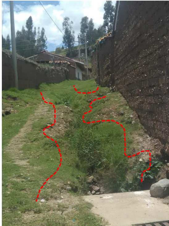
Puente de paso de la acequia que cruza la calle principal. La transversal está destinada a un proceso de destrucción y formación de cárcavas por el agua de las lluvias temporales. Huaripampa
