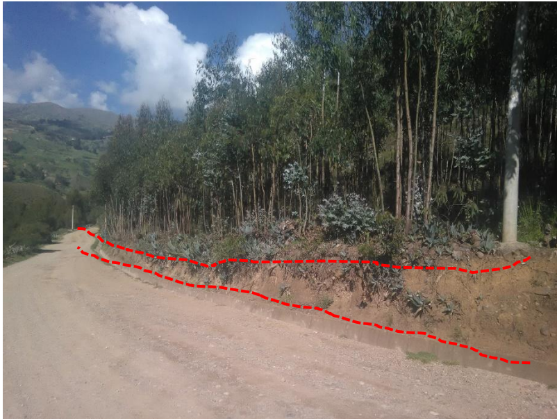
Carretera Puente Bedoya- Villa Olleros , bosque de eucalipto al margen como medio de control del desmoromiento y los derrumbes. Villa Olleros.
