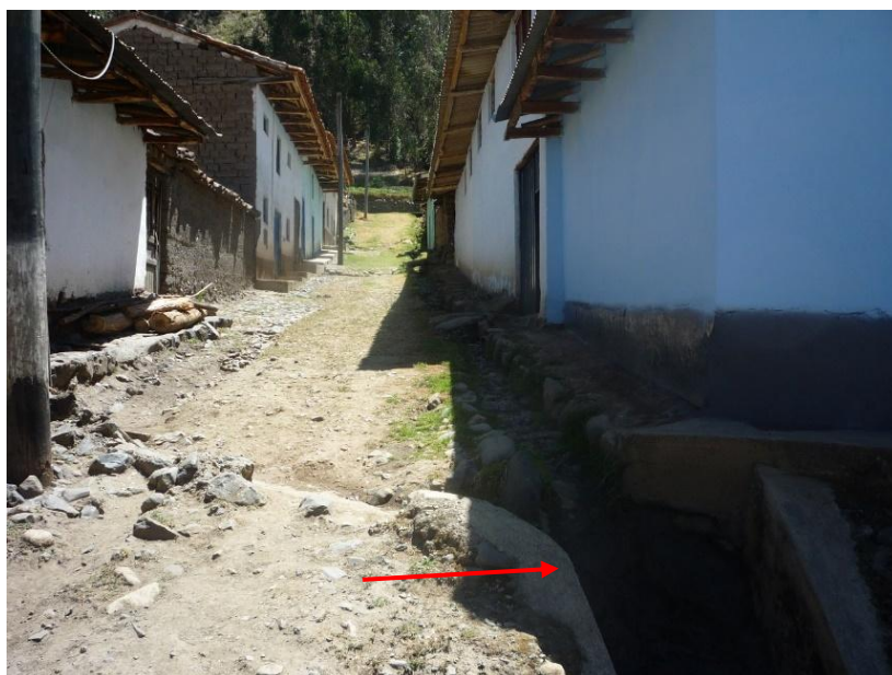
Intersección de Jr. Belén y la Av. Dagoberto Cáceres, la acequia que cruza la Av. Está recubierto con cemento y aguas arriba, está empedrado, lo que detiene la erosión vertical – Villa Olleros.
