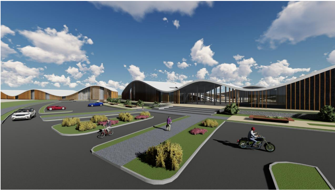
Figura 90: Vista Panorámica del Proyecto 1 Fuente: Elaboración Propia
