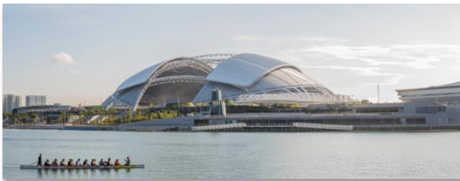
Figura 8. Centro Deportivo Singapur
