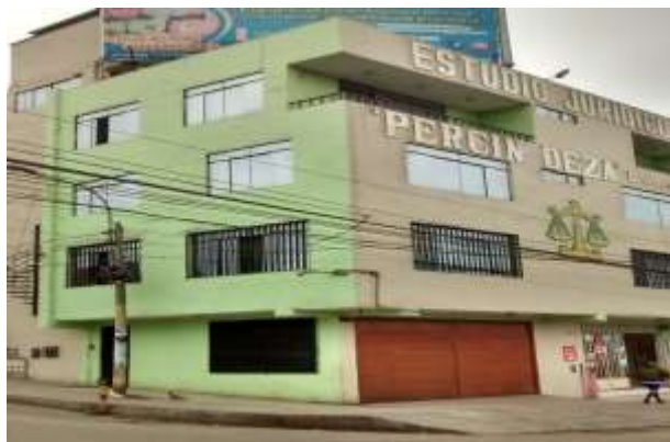
Figura 36. Vivienda que presenta 5 Pisos. Mz 92 Lt 01 – AA.HH La Flor Etapa 1 – Carabayllo. Fuente: Elaboración Propia
