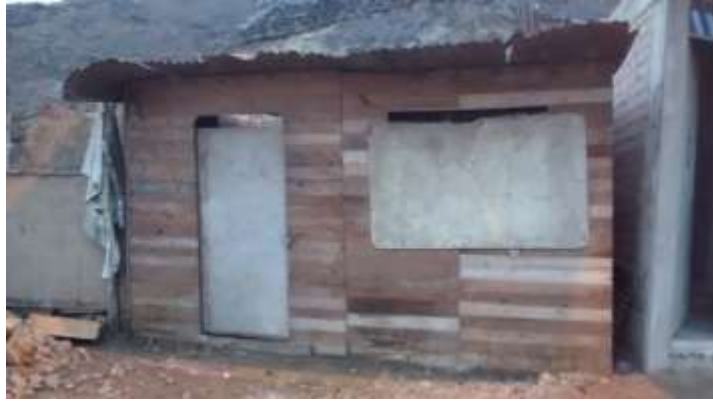
Figura 18. Vivienda no cuenta con “Ningún” Principal Elemento Estructural AA.HH La Flor Etapa 2, Sector II – Mz C Lt 03 – Carabayllo. Fuente: Elaboración Propia
