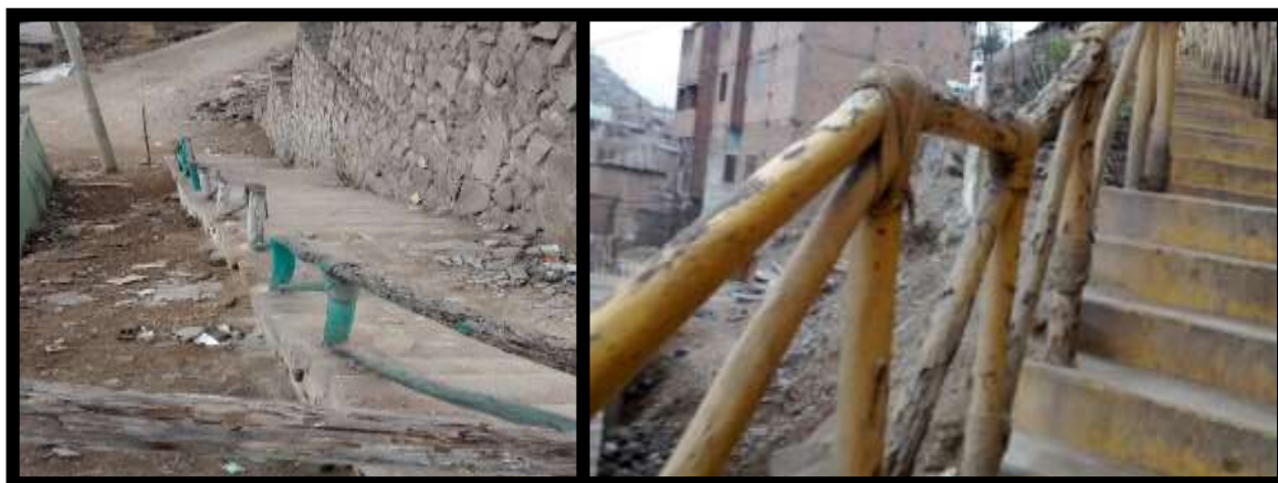
Figura 7: En el lado izquierdo, vista de la escalera denominada Pasaje 4, AAHH. La Flor 3º Etapa y al lado derecho, vista de la escalera denominada Pasaje Santa María, AA. HH La Flor 1º Etapa. Diversas escaleras evidencian presencia de material suelto como piedras, las cuales obstaculizan el tránsito de los mismos habitantes. De la misma forma se visualiza un notable deterioro de las escaleras, muchas de ellas sin presencia de barandas las cuales hacen que la población se torne más vulnerable ante la ocurrencia de un sismo. Fuente: Elaboración Propia
