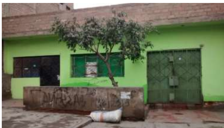
Figura 20. Vivienda con presencia de Cimiento, Columna, Muro, Viga y Losa AA.HH La Flor Etapa 1 - Mz 79 Lt 03. Fuente: Elaboración Propia
