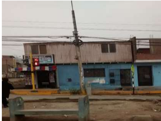
Figura 24. Vivienda con presencia de Madera como Material predominante en el Techo. Mz 90 Lt 01 – AA.HH La Flor Etapa 1 – Carabayllo. Fuente: Elaboración Propia
