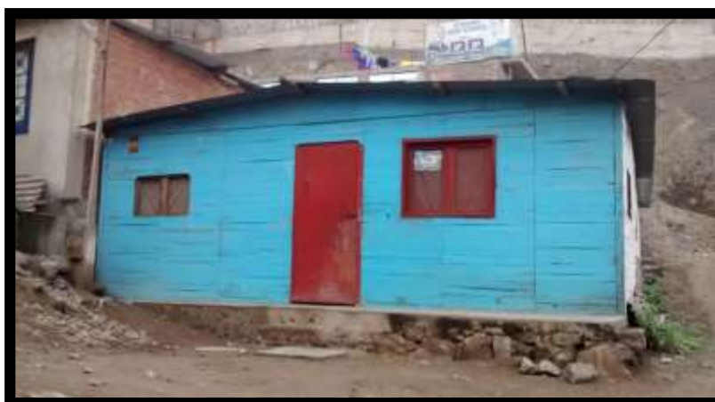
Figura 9: Viviendas del AA. HH La Flor, 1º Etapa. Se observaron ciertas viviendas que estaban asentadas sobre áreas que estaban destinadas para otro tipo de usos (no residenciales). Fuente: Elaboración Propia
