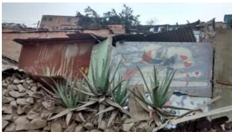
Figura 22. Vivienda que presenta Triplay como material predominante en las paredes. Mz D Lt 02 – AA.HH La Flor Etapa 2, Sector 1 – Carabayllo. Fuente: Elaboración Propia
