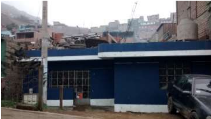
Figura 39. Vivienda que presenta Objetos Pesados como Cargas Vivas en el Techo. Mz 83 Lt 02 – AA.HH La Flor Etapa 1 – Carabaylo. Fuente: Elaboración Propia
