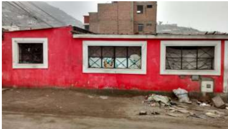
Figura 19. Vivienda con presencia de Cimiento y Muro AA.HH La Flor Etapa 1 – Mz 80 Lt 05 – Carabayllo. Fuente: Elaboración Propia
