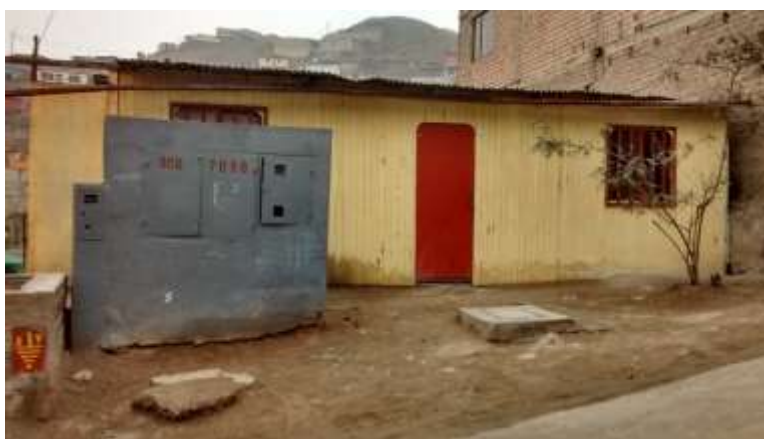
Figura 34. Viviendas cuya pendiente es de 20 a 30%. Mz 81B Lt 06 – AA.HH La Flor Etapa 1- Carabayllo. Fuente: Elaboración Propia
