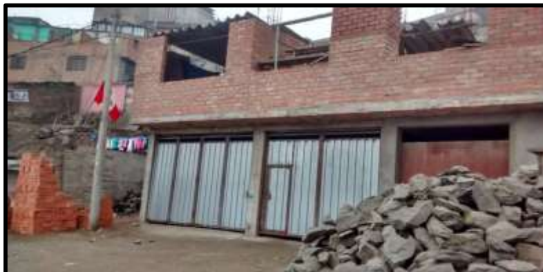
Figura 8. Vivienda en proceso de reforzamiento. AA. HH La Flor Etapa 2 Sector 2. Fuente: Elaboración Propia
