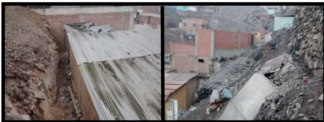
Figura 6: Fotografías de viviendas ubicadas en la parte alta del AA. HH La Flor 2º Etapa, Sector II, donde se pueden apreciar que diversas viviendas quedan expuestas a deslizamientos de roca, las cuales se tornan aún más vulnerables ante la ocurrencia de un sismo o lluvias intensas. Fuente: Elaboración Propia
