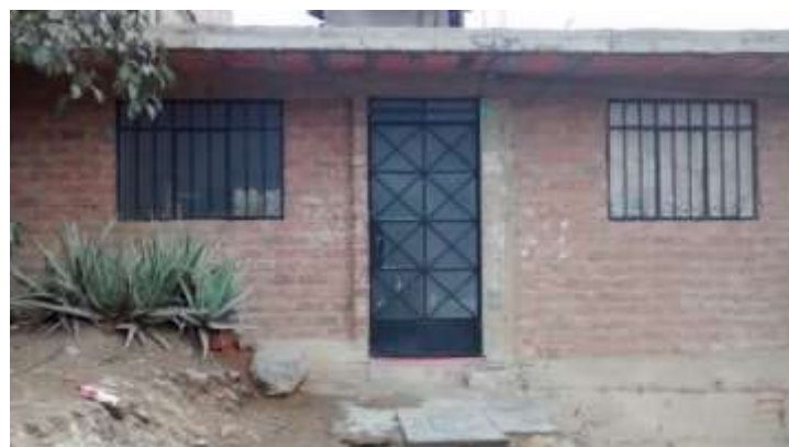
Figura 26. Vivienda con presencia de Concreto como Material predominante en el Techo. Mz F Lt 01 – AA.HH La Flor Etapa 2, Sector I – Carabayllo. Fuente: Elaboración Propia
