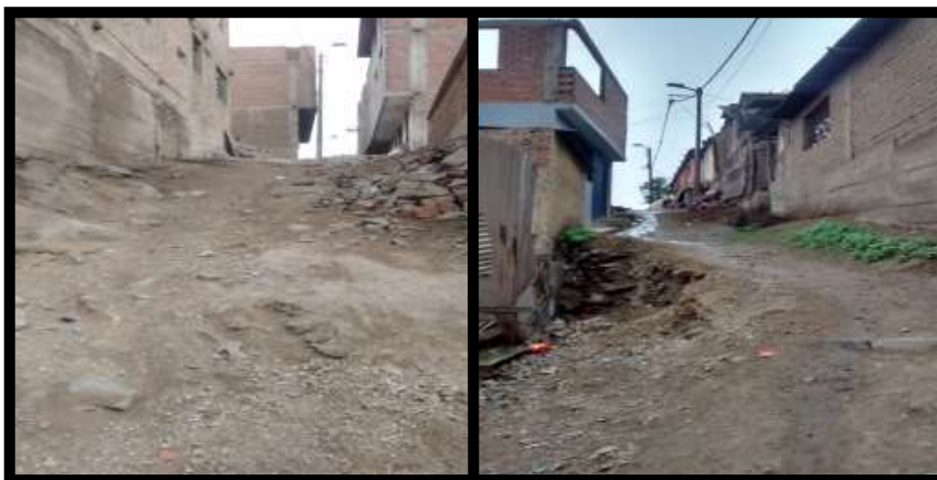
Figura 8: En el lado izquierdo, vista del pasaje Las Tunas, AAHH. La Flor 2º Etapa, Sector II, y al lado derecho, vista del pasaje Las Violetas, AA. HH La Flor 2º Etapa, Sector II. Muchos de estos pasajes presentan caminos muy dificultosos para el libre tránsito, debido que no han sido trabajados adecuadamente, los cuales pueden exponer a la población más vulnerable del asentamiento humano. Fuente: Elaboración Propia
