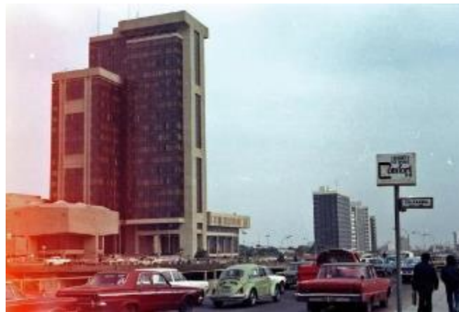
Figura 14 Lima “Edificio PETROPERU” – 1970
