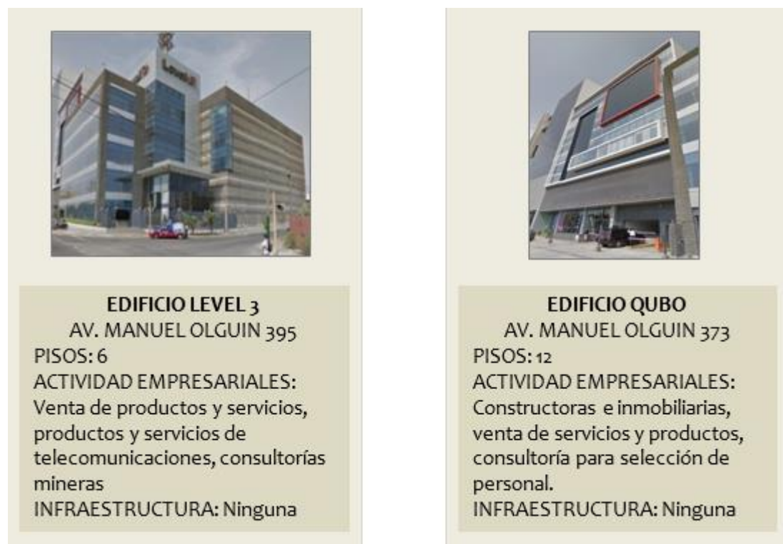
Figura 24 Oficinas en el Eje de la Av. Olguín
