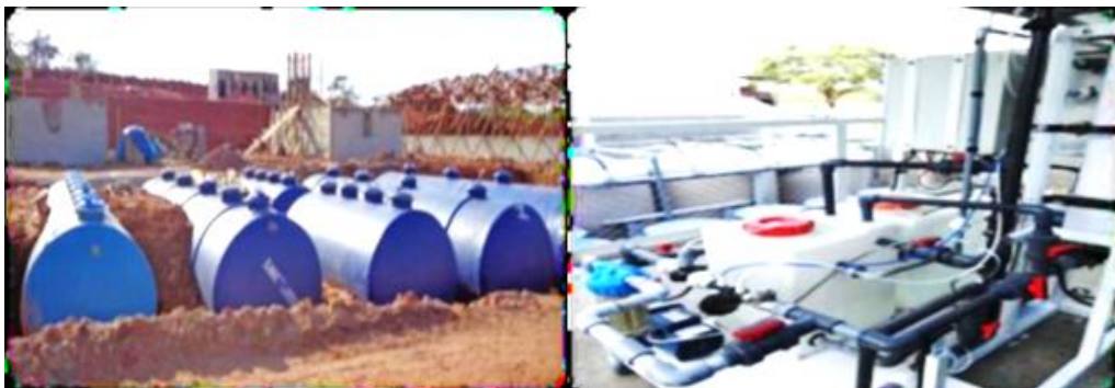
Figura N°A. 12: MONTAJE DE TANQUES DE TRATAMIENTO Y EQUIPOS SISTEMA COMPACTO
