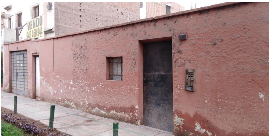
Vivienda de adobe en malas condiciones en el distrito de Jesús María.
