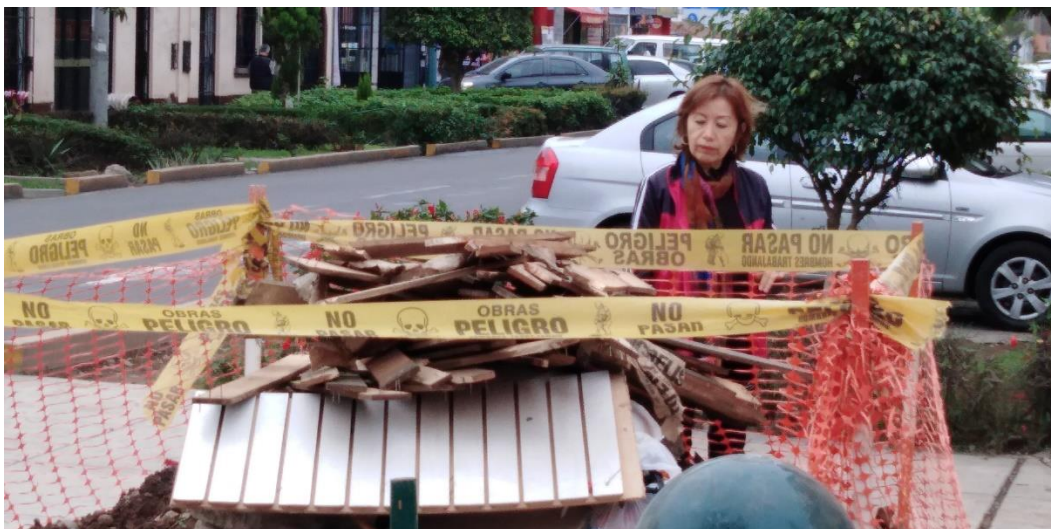
Desmontes de construcción ocupando veredas peatonales.
