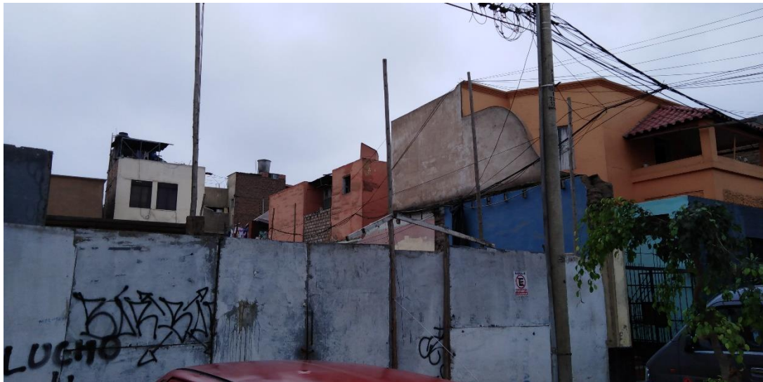
Terreno cercado por demolición para futura construcción.
