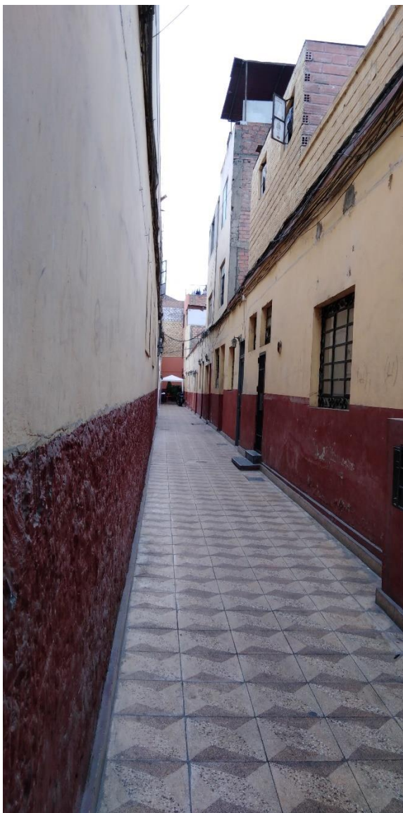
Quinta típica en el distrito de Jesús María con material mixto de adobe y ladrillo.
