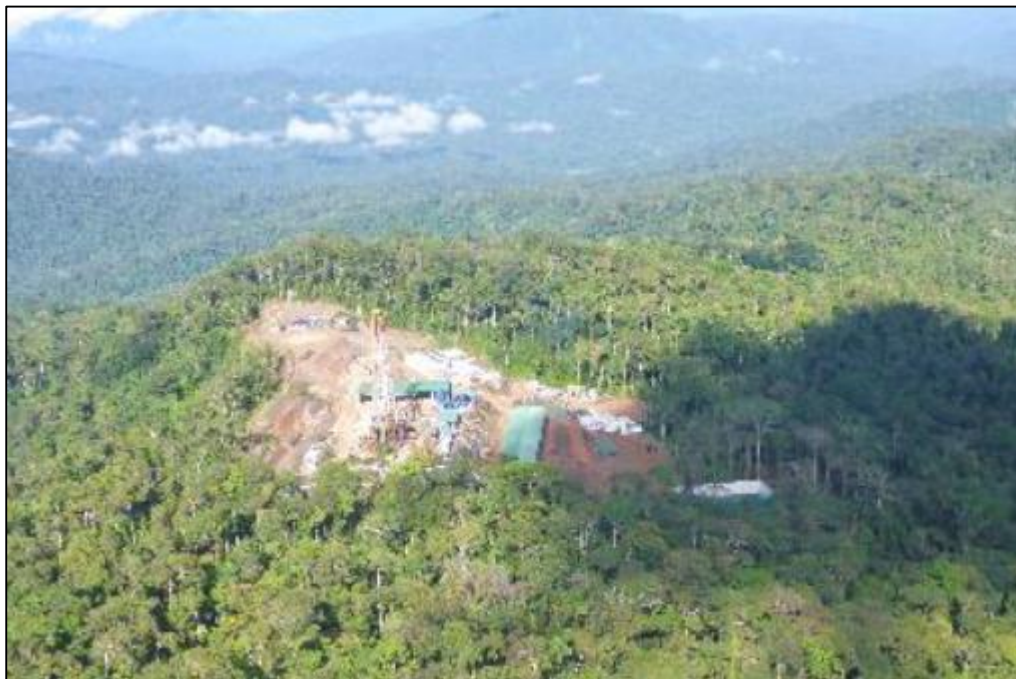
Figura 23: Locación PAD A durante la construcción
