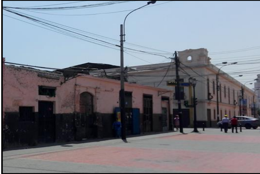
Figura 38. Jirón Hualgayoc N° 381, 383, 385, 387, 389, 393, 395, 397, 399 y esquina con jirón Cajamarca.
