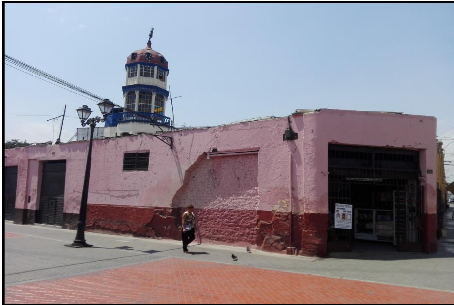
Figura 30. Jirón Hualgayoc esquina con jirón Marañón.
