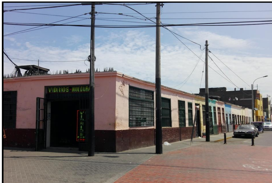
Figura 36. Esquina Jirón Hualgayoc s/n esquina con jirón García Hurtado de Mendoza N° 321, 325, 333, 347, 355 y 361.
