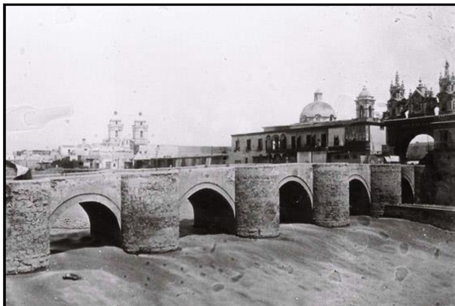
Figura 3. Primer Puente de Piedra del Rímac
