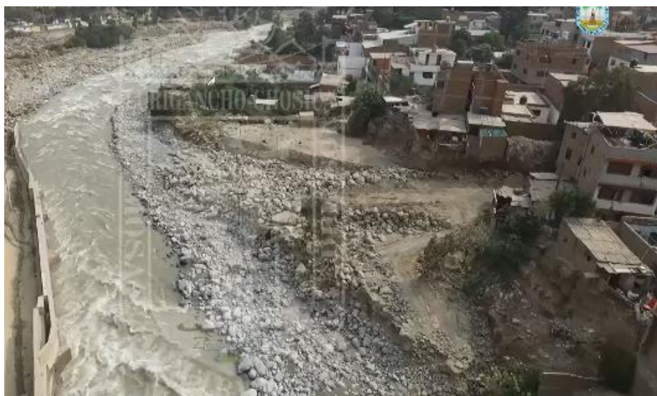
Figura 40. Descarga de la quebrada Pedregal al rio Rímac
