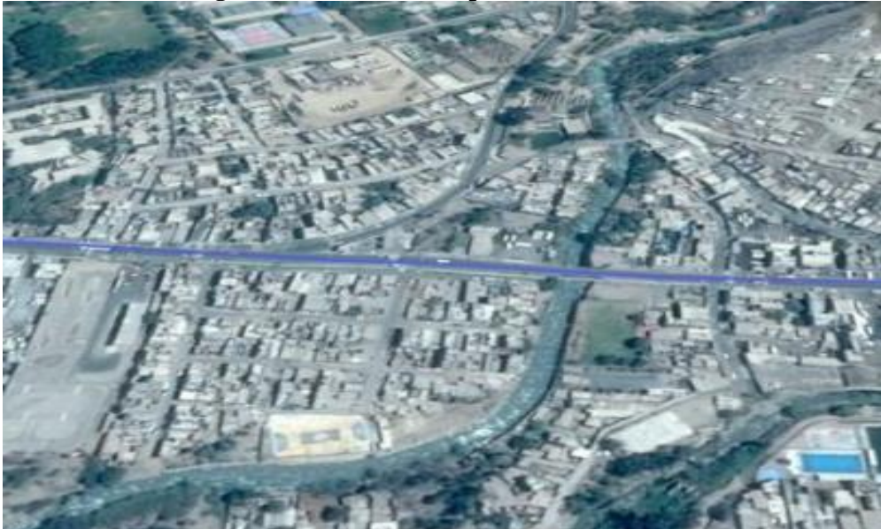
Figura 19. Ubicación del puente Santa Eulalia
