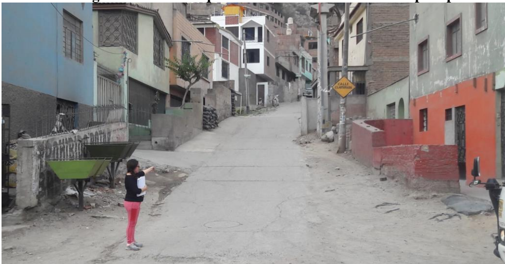
Figura 28. Vista aguas arriba de la quebrada – salida al río interrumpida por viviendas
