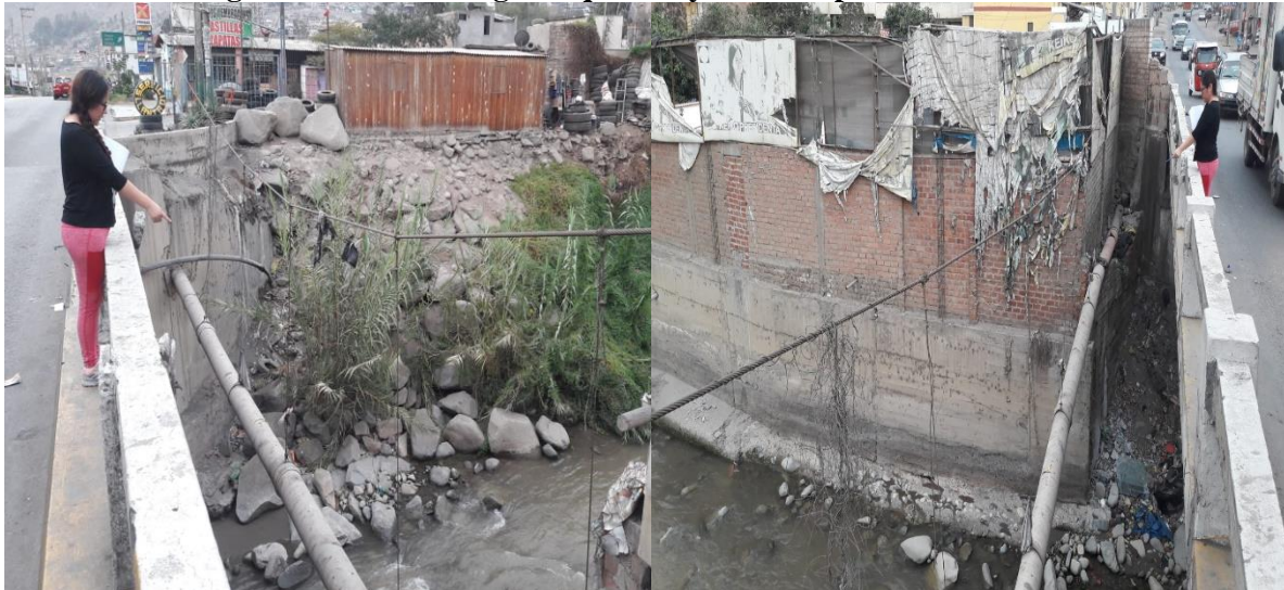
Figura 20. Vista Margen Izquierdo y Derecho puente Santa Eulalia
