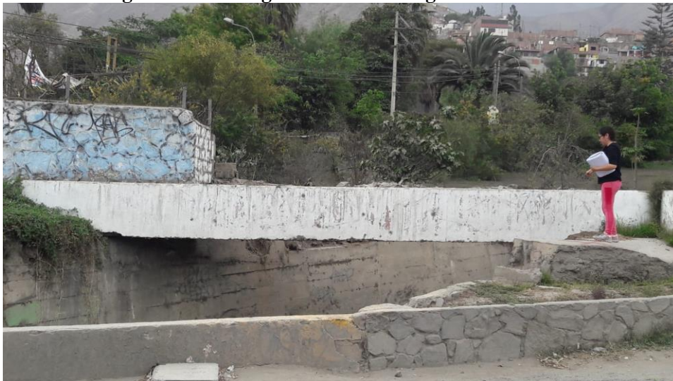
Figura 24. Vista aguas arriba descarga Km.29+687.63
