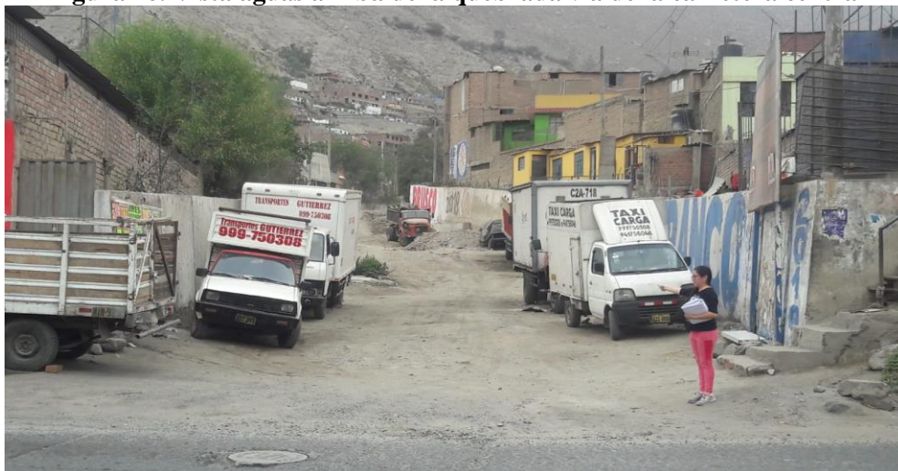
Figura 26. Vista aguas arriba de la quebrada vía de la carretera central
