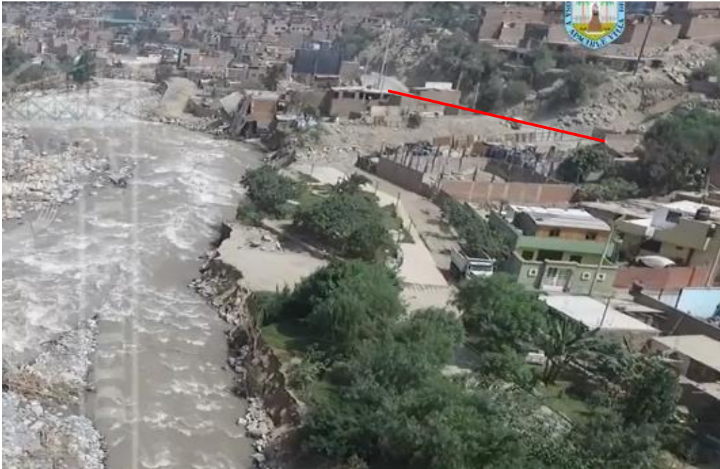
Figura 43. Descarga de la quebrada Corrales (Rayitos de Sol) al río Rímac
