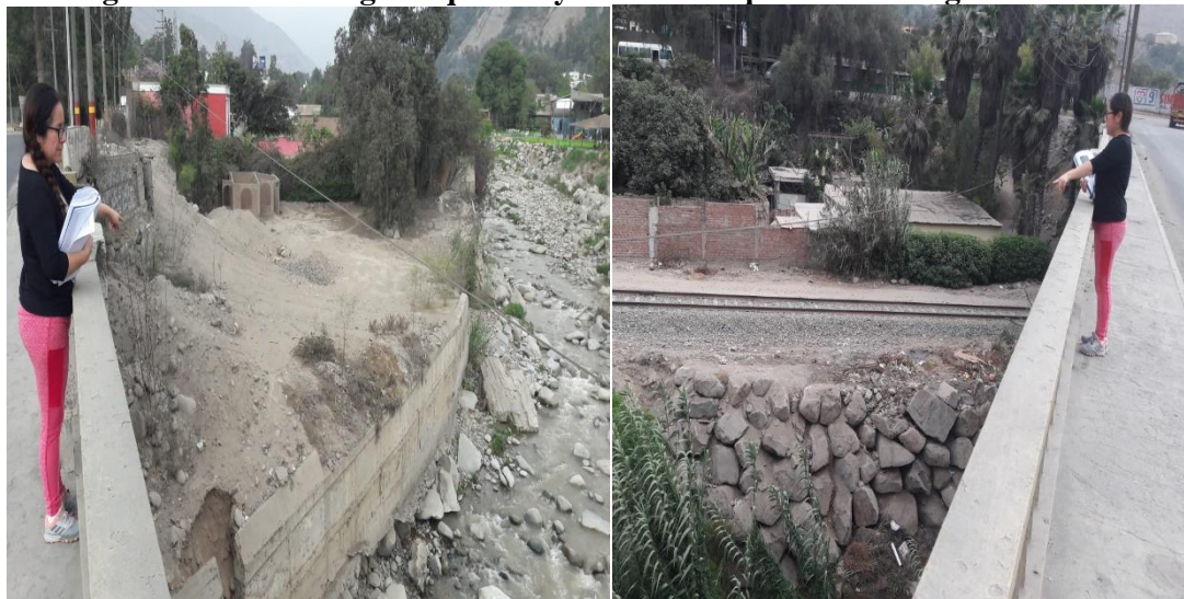
Figura 18. Vista margen izquierdo y derecho del puente Los Ángeles
