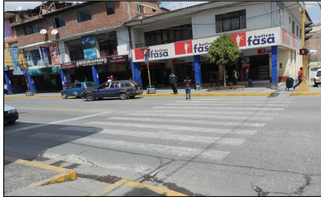
Fotografía N° 11, Línea de paso peatonal en Av. Luzuriaga
