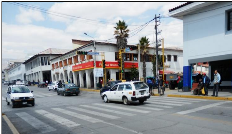
Fotografía N° 6: Grietas transversales y de esquina en pavimento (Av. Luzuriaga con Jr. José de Sucre)
