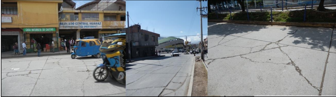
Fotografía N° G.04: Grietas características en el pavimento de algunas vías, Jr. 27 de Noviembre, Conf. Int. Oeste, Av. Luzuriaga
