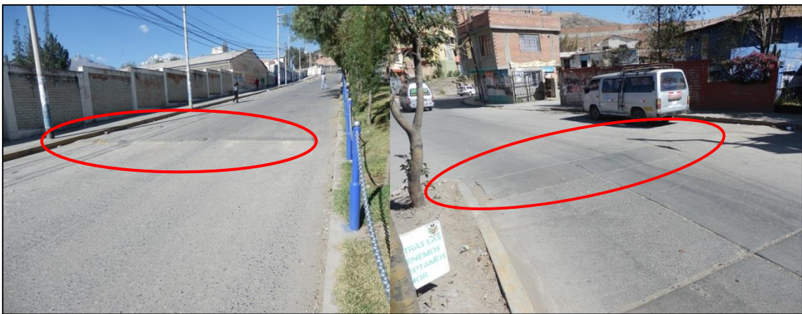
Fotografía N° G.03: Rompemuelles no perceptibles (Sin pintar y sin señal de cercanía del mismo), Av. Villón, Av. Conf. Int. Oeste
