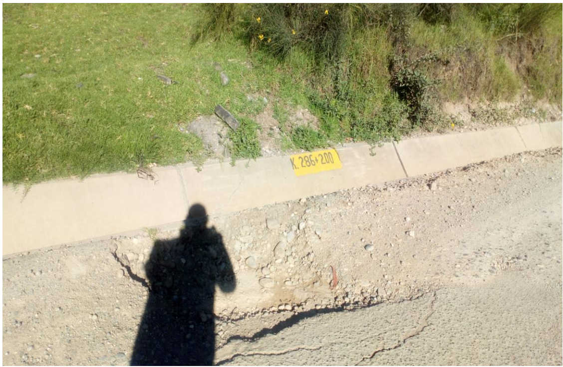
FOTO N° 07 FALLA DE ASFALTO POR PRESENCIA DE HUMEDAD EN LA ESTRUCTURA DEL PAVIMENTO.
