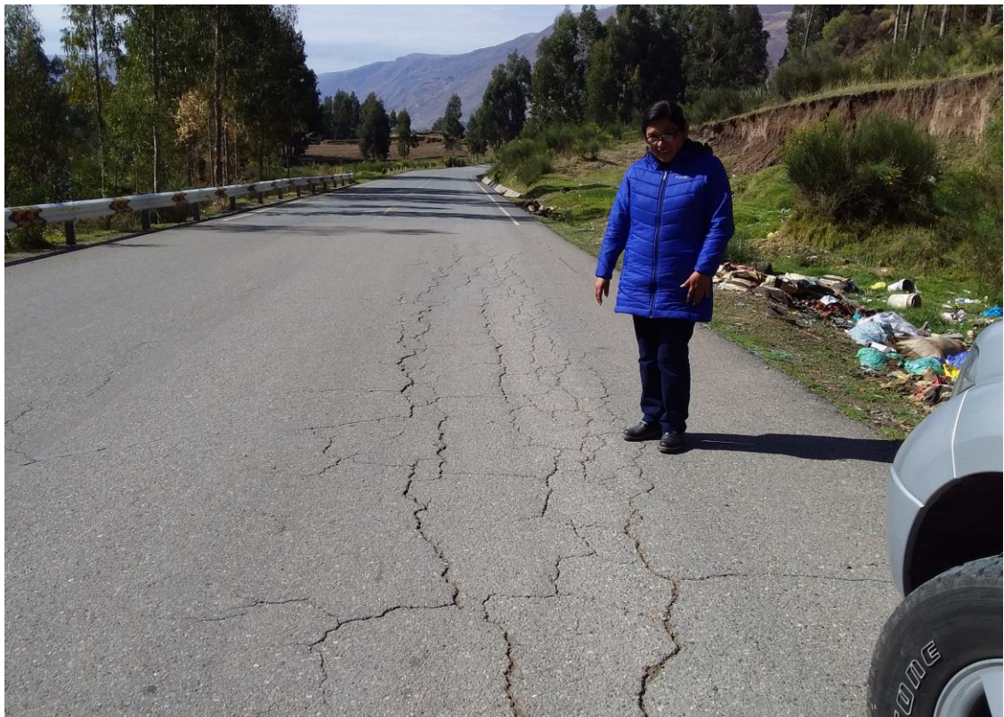
FOTO N° 07 FALLA DE ASFALTO POR PRESENCIA DE HUMEDAD EN LA ESTRUCTURA DEL PAVIMENTO.
