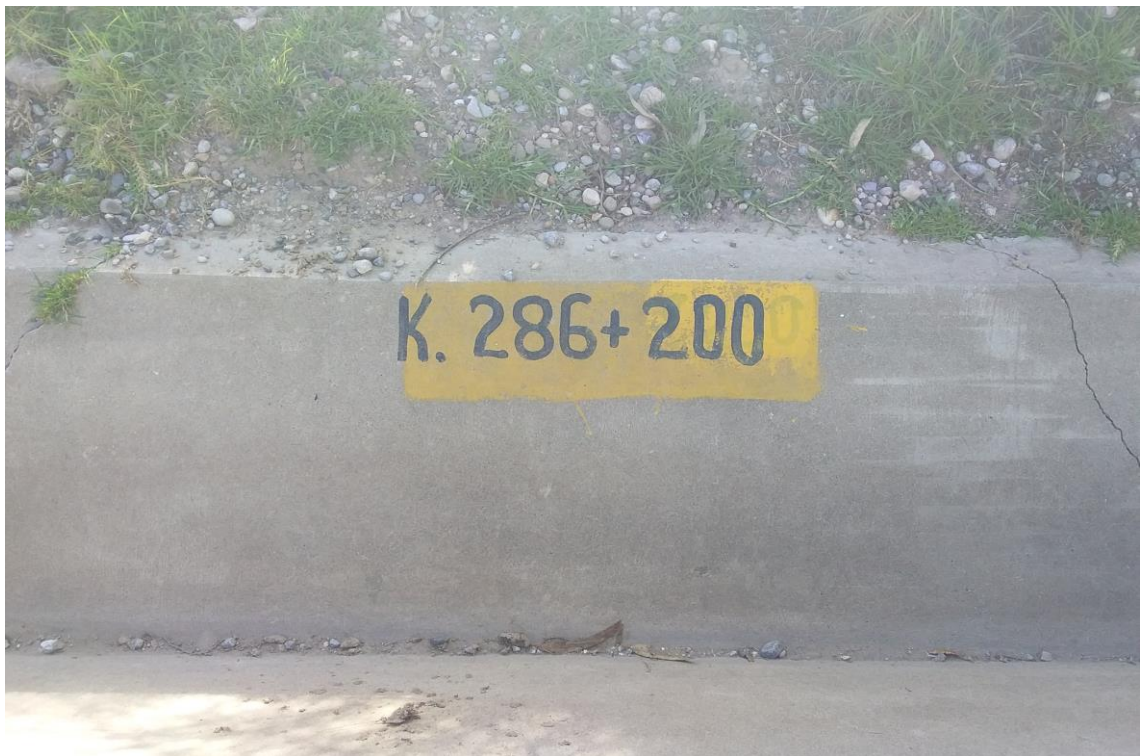
FOTO N° 02 PROGRESIVA KM. 286 +200 DE CANTERA DE CARRETERA
