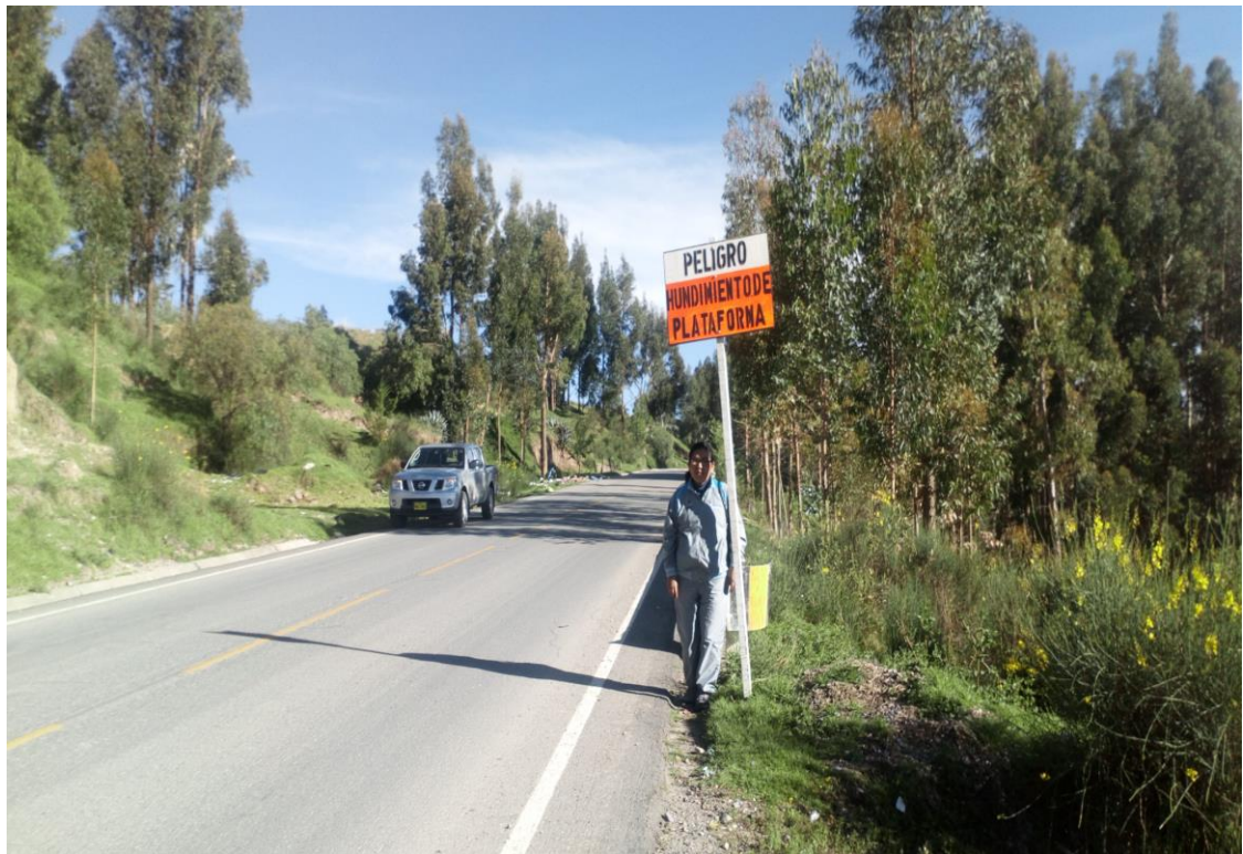
FOTO N° 09 SEÑAL VERTICAL DE HUNDIMIENTO DE PLATAFORMA
