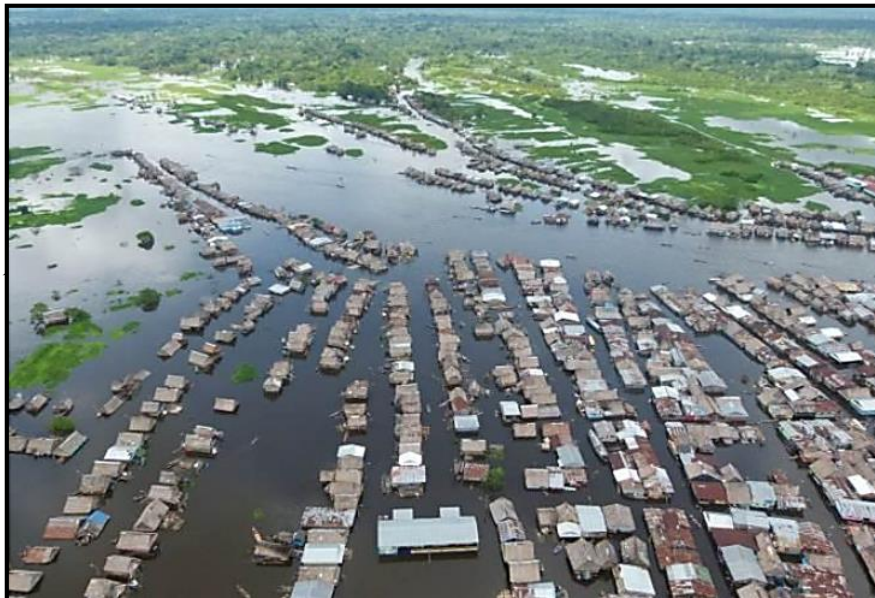
Figura 16: Vista aérea del Sector crítico totalmente inundado.
