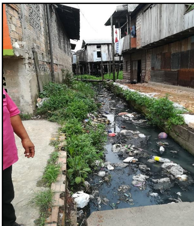
Figura 24: Alto grado de contaminación producto del empozamiento de aguas residuales, que generan malos olores en la Zona Baja de Belén.
