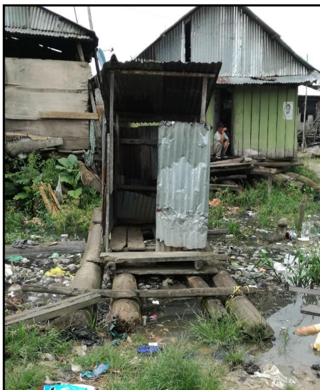
Figura 23: Letrinas precarias usadas por la población, donde se aprecia el alto grado de contaminación al curso de las aguas.
