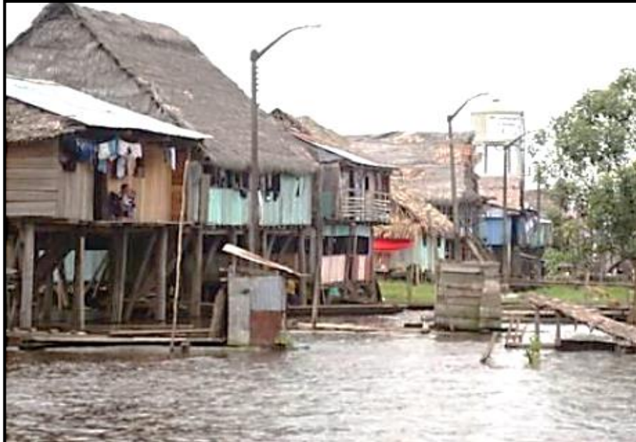
Figura 12: Letrinas instaladas al borde del piso, el mismo que en épocas de crecida se elevarán.
