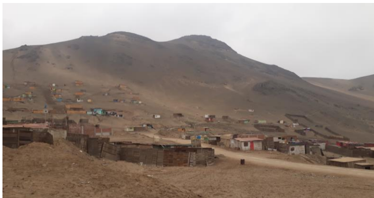
Figura 17: Vista panorámica, Zona 1. Viviendas en la ladera de cerro AA. HH. Adesesep. Fuente: Elaboración propia. Fecha: 20-06-2019
