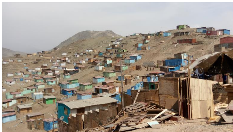
Figura 18: Vista panorámica, Zona 2. Viviendas en la ladera de cerro en el AA. HH. Mujeres por un País Mejor. Fuente: Elaboración propia. Fecha:24-01-2018
