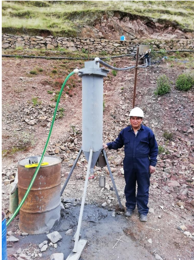
Foto 15: Instalación de la planta de pilotajes de pasta
