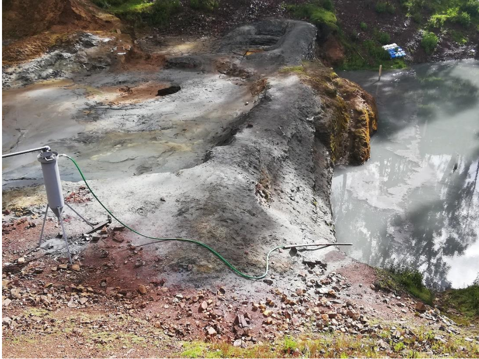
Foto 17: Instalación de la descarga de agua clarificada
