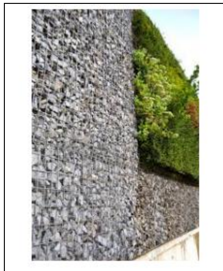
Figura 18. Gaviones de metal
