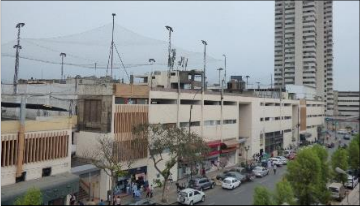
Vista lateral de la edificación Comercial Centro Lima
