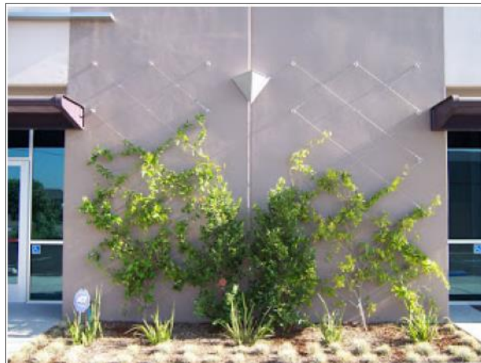
Figura 6. Sistema de cables en forma de rombos
