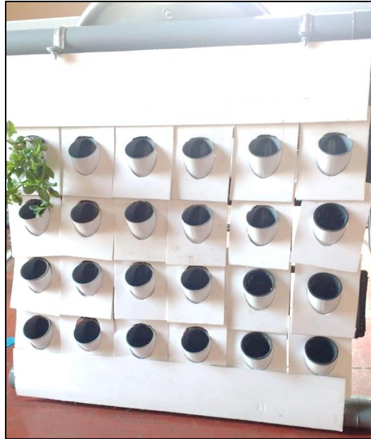
Figura 40. Instalación del recubrimiento del Jardín vertical
