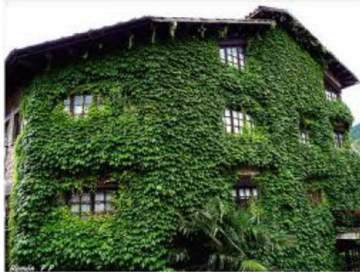
Figura 5. Fachada cubierta de hiedra
