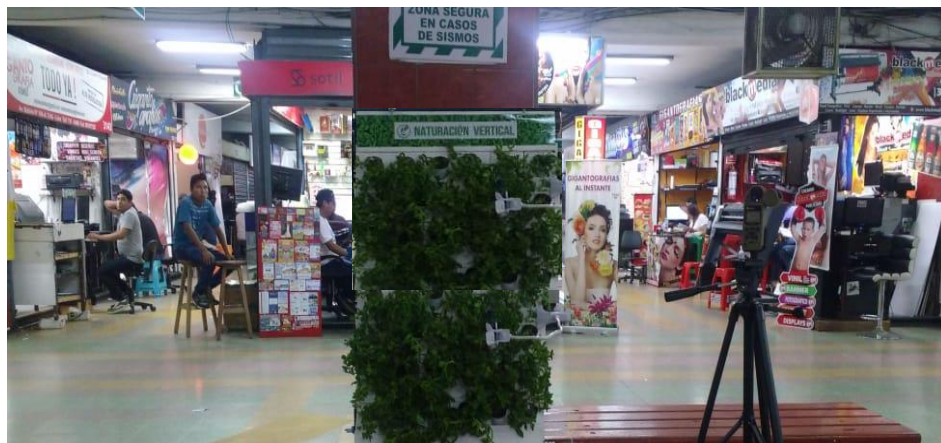
Figura 43. Naturación vertical piloto dentro de la edificación comercial.
