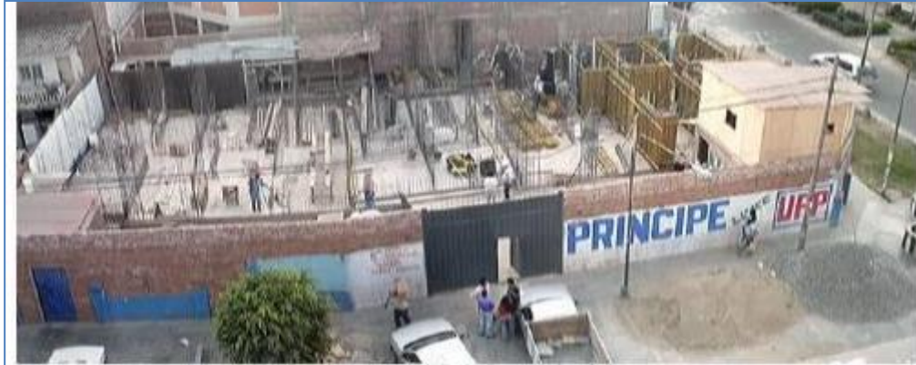
Figura 16. Constructabilidad en el abastecimiento
