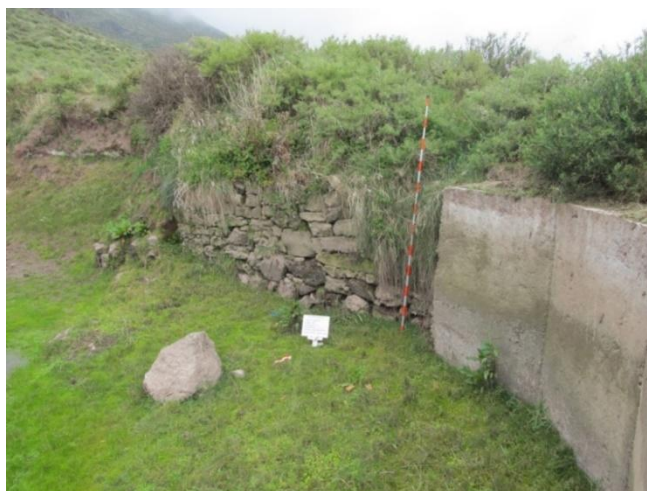
Figura 80: Vista S-N de parte de un muro del reservorio. Sector II.
