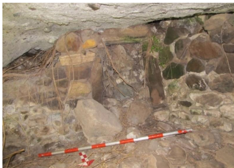
Figura 24: Detalle del vano de forma trapezoidal dentro del machay II (N-S).
