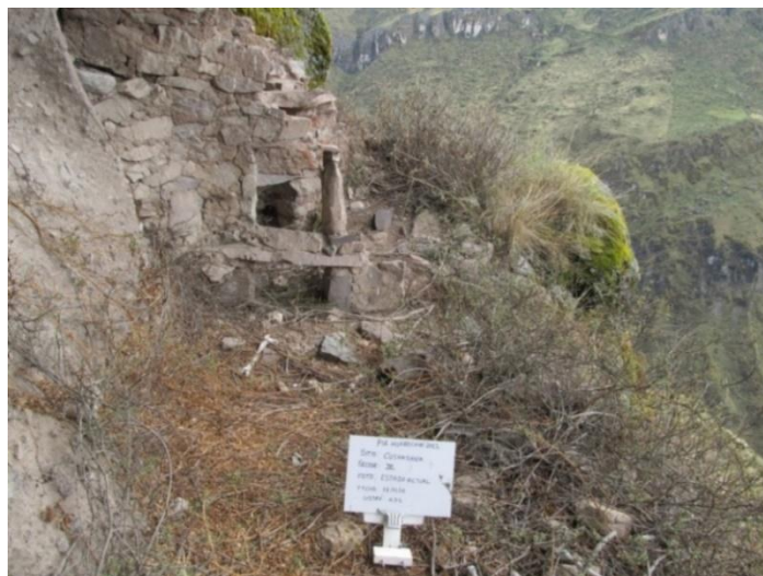
Figura 84: Detalle S-N de una de las estructuras que presenta el machay.
