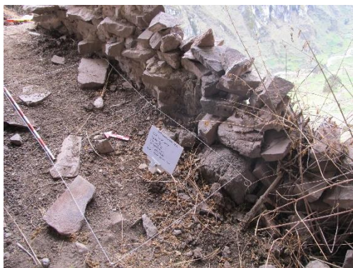
Figura 115: Vista O-E de piedras caídas de la estructura.
