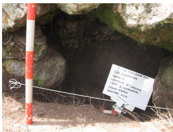
Figura 68: Tierra húmeda debido a una filtración.
