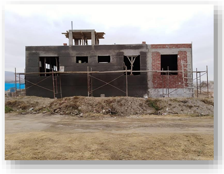
Figura 29. Construcción del nuevo Centro de visitantes(vista lateral) Fuente: Trabajo de campo
