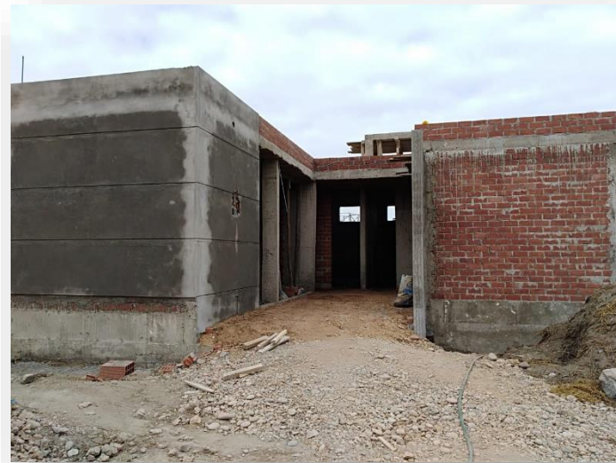
Figura 28. Construcción del nuevo Centro de visitantes(vistal frontal) Fuente: Trabajo de campo
