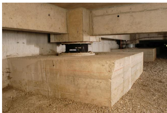
Figura 2.45: Aisladores colocados directamente sobre capitel de las zapatas
