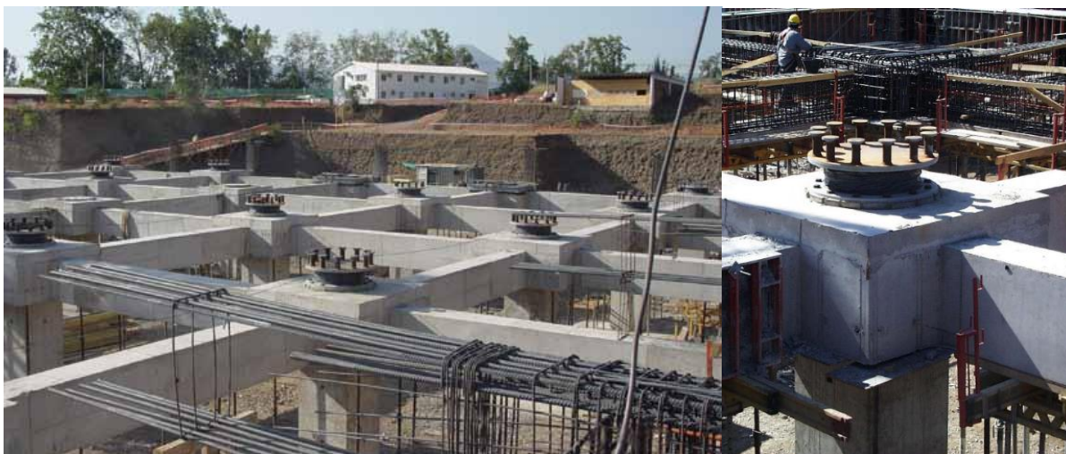
Figura 2.81: Ubicación de los aisladores sísmicos en la parte superior del sótano Fuente: (BIT Revista, 2012)
