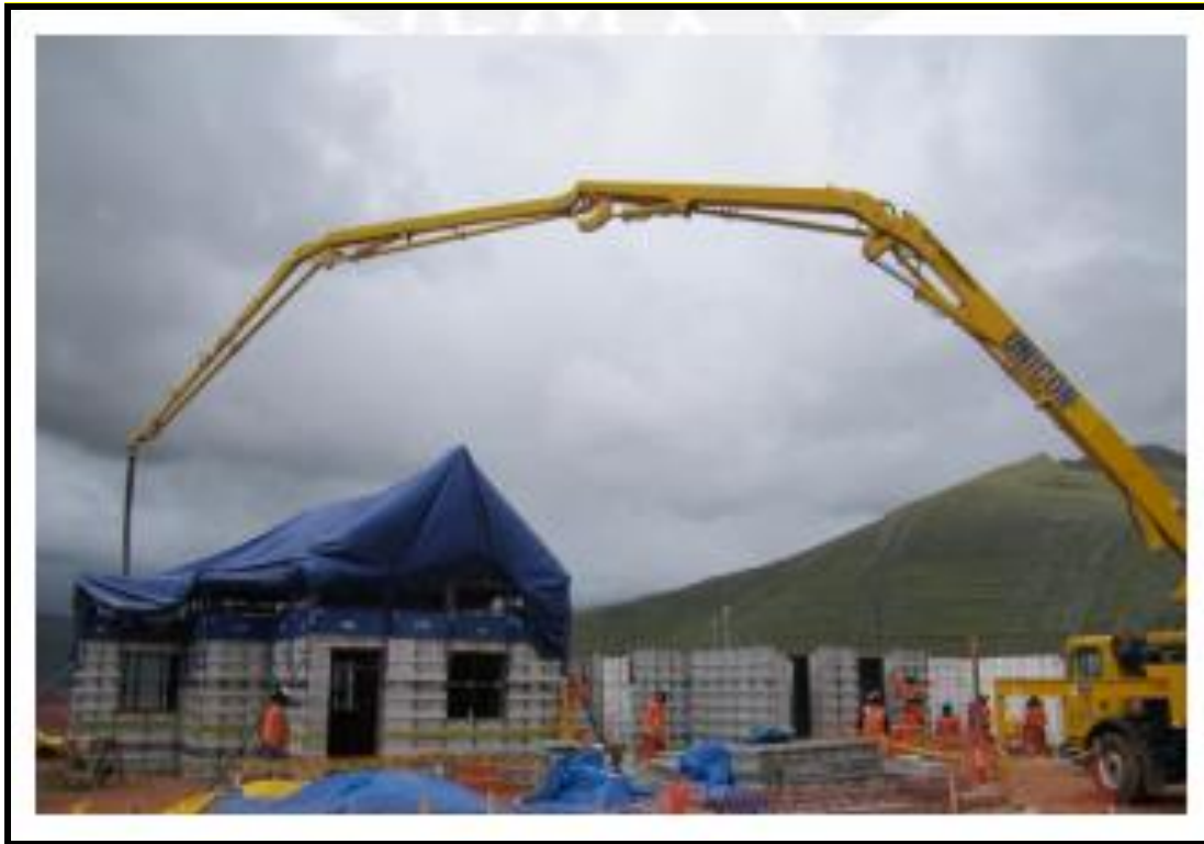
Figura 11. Proceso de construcción del casco estructural
