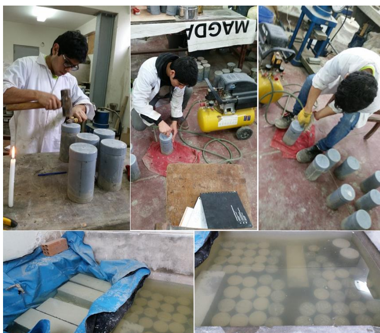
Figura 68. Desencofrado y curado de probetas y vigas de concreto. Fuente. Elaboración propia.
