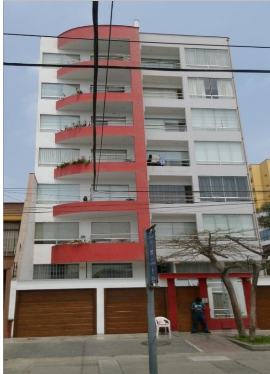
Figura 9. Edificio de 07 pisos. Av. León García N° 565 Sta. Catalina. Fuente: Elaboración propia.
