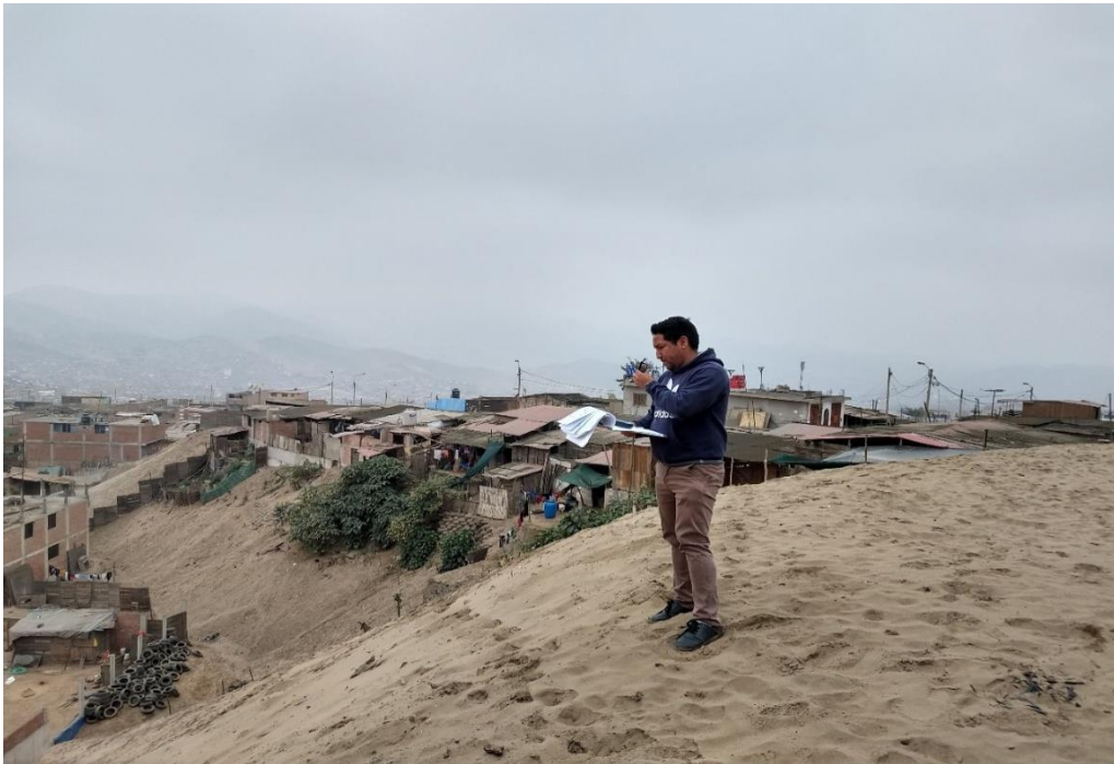
Foto 11 Infraestructura en Ciudad Pachacutec
