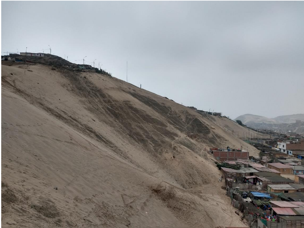
Foto 28 Viviendas vulnerables a cualquier desastre
